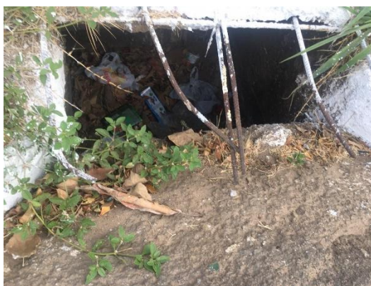
Figura 14 - Boca de Lobo apresentando entupimento – Av. Canaã
