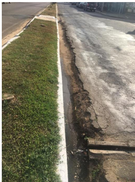
Figura 13 – Danos no pavimento e sarjeta – Av. Canaã
