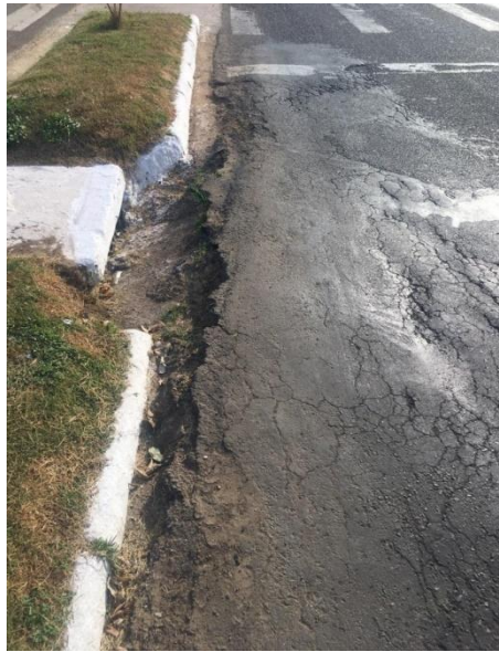
Figura 12 – Danos no pavimento asfáltico comprometendo o fluxo da água até a boca de lobo – Av. Canaã
