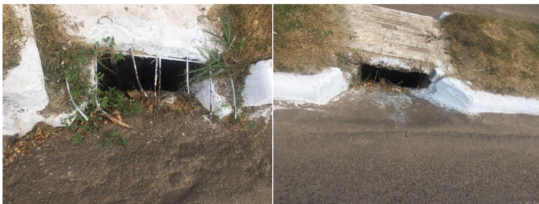
Figura 11 - Bocas de lobo danificadas – Avenida Canaã
