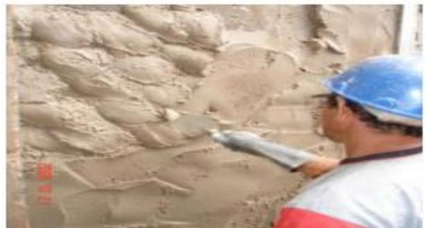
A aplicação mecanizada é considerada um processo mecânico, que a energia de lançamento da massa não admite modificações, como na aplicação manual. Além do mais, a projeção da argamassa possibilita que a aderência do material na área seja contínua, impossibilitando que se criem vazios resultantes do lançamento manual.
