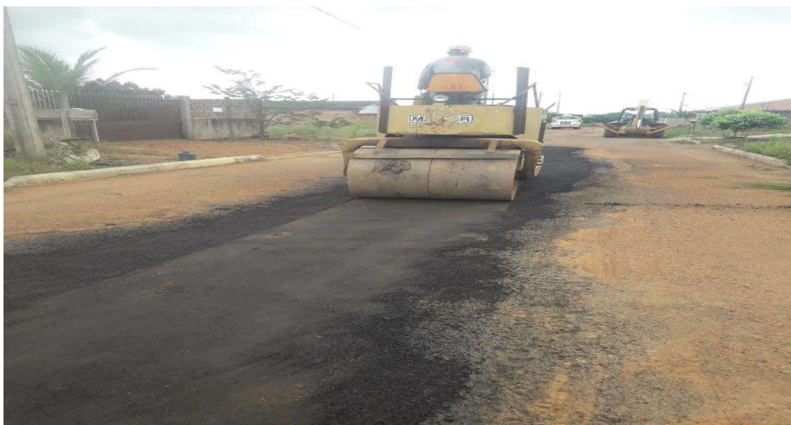
Figura 20-Compactação da mistura betuminosa e alinhamento com a pista.
