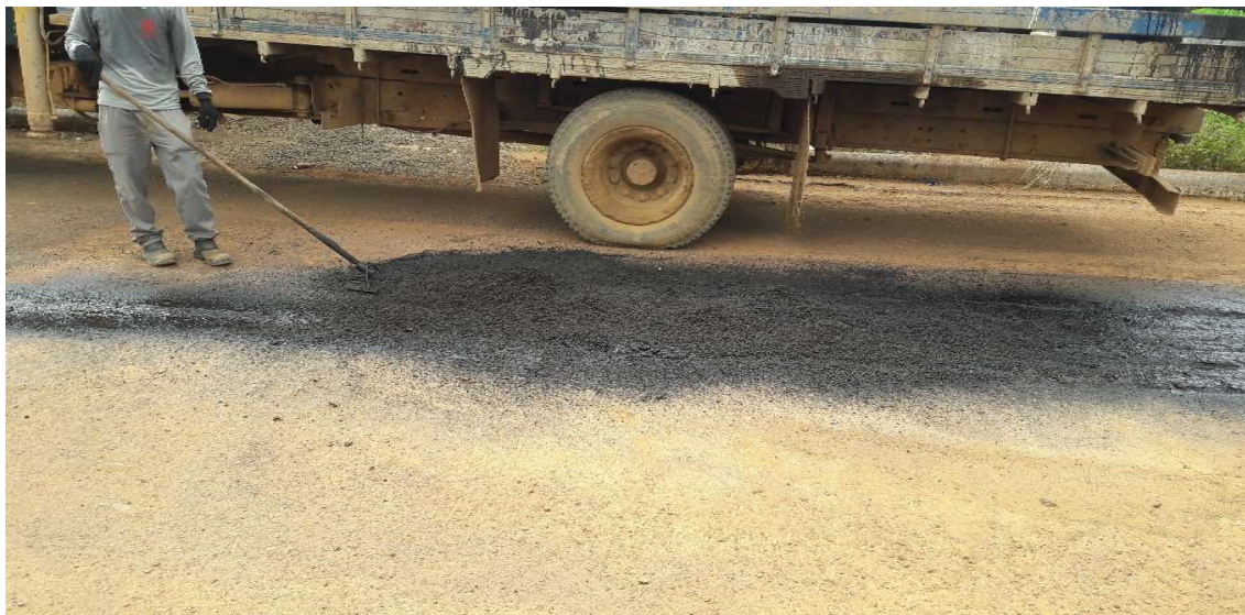
Figura 19-Aplicação da mistura betuminosa- PMF.
