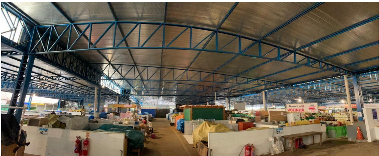
Figura 13 – Estrutura do telhado
