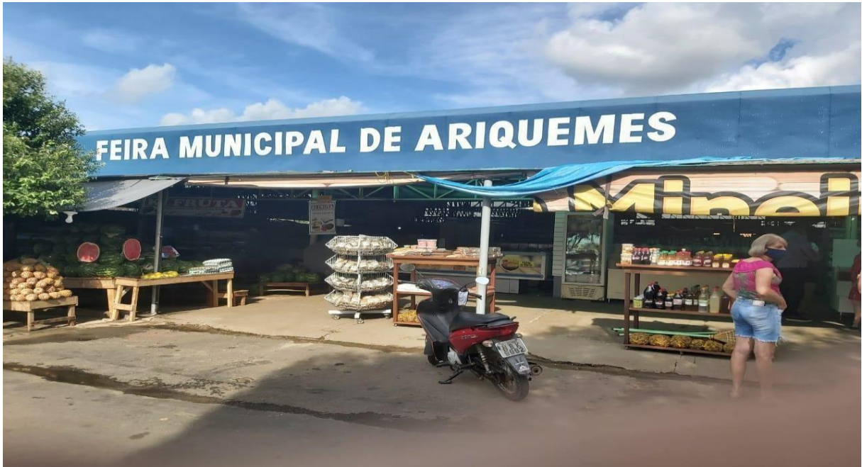
Figura 12 – Fachada Principal da Feira Municipal de Ariquemes
