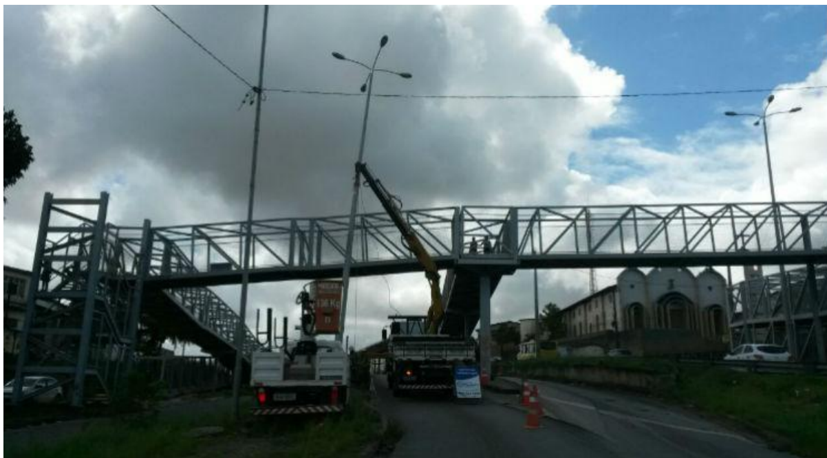
Figura 8 – Vista da estrutura física da passarela
