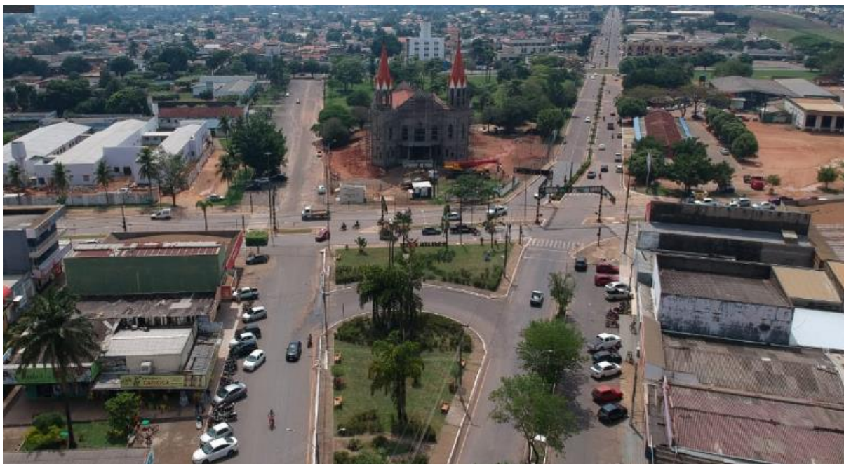
Figura 3 – Vista aérea da confluência das Av. Jamari com Av. Tancredo Neves
