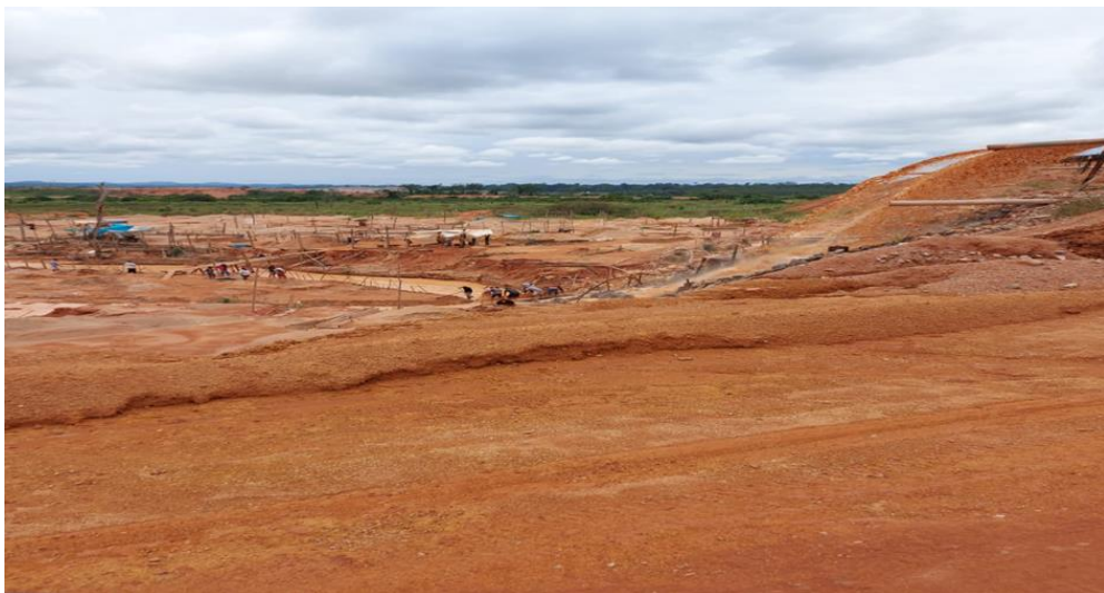
Figura 19 – Trabalhadores informais no ponto de emissão de rejeito
