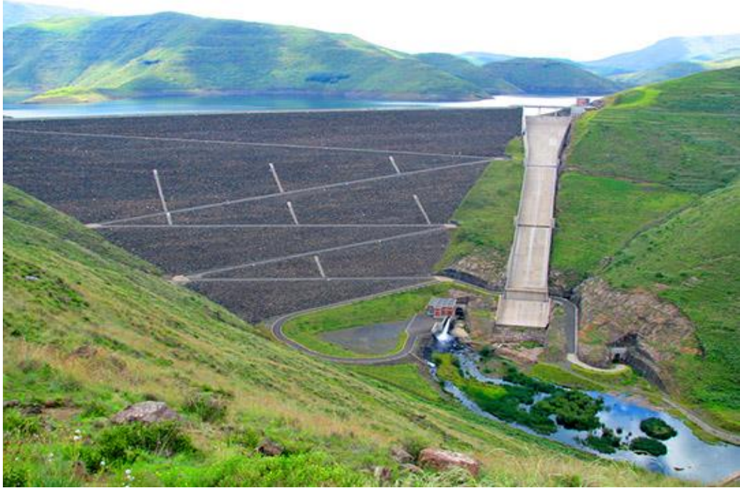
Figura 6 - Barragem de enrocamento.
