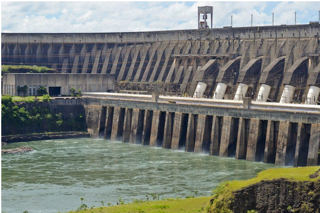
Figura 7 - Barragem de concreto.
