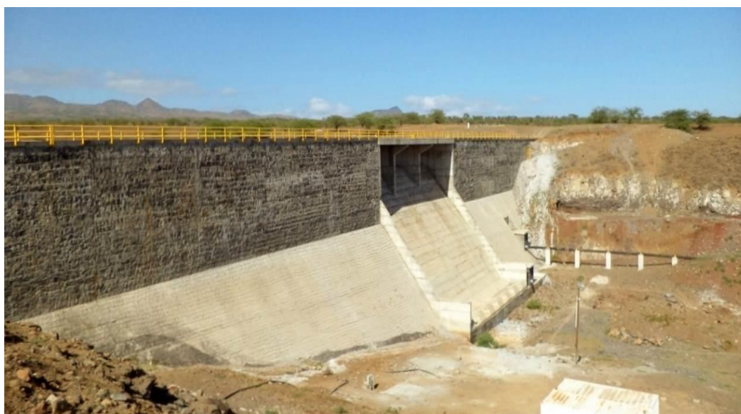
Figura 11 - Barragem de alvenaria de pedra.
