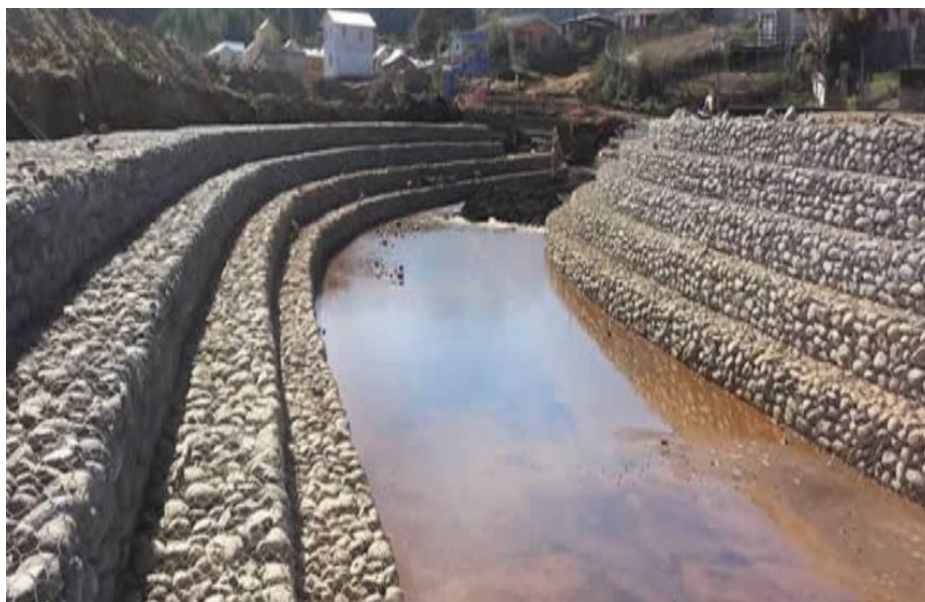
Figura 9 - Barragem de Gabião.
