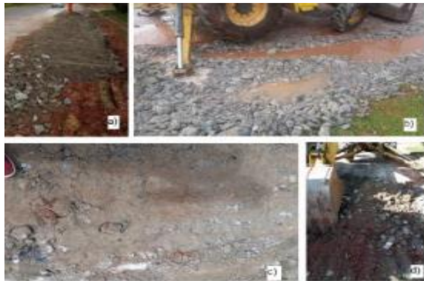
Figura 6 – Utilização de Resíduos como reforço de base
