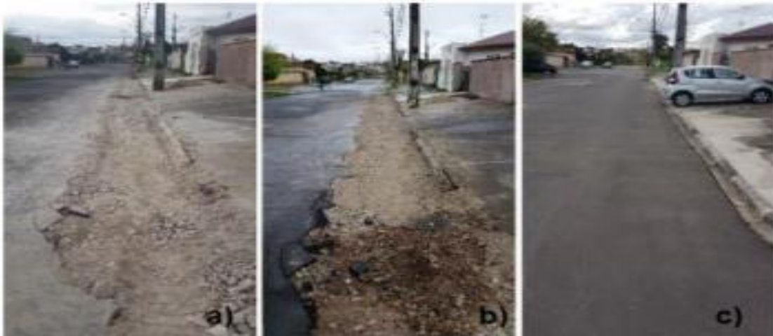
Figura 7 – Utilização de Resíduos de Construção Civil como base de complemento de pavimento
