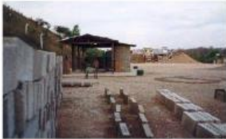
Figura 3 – Usina de reciclagem de RCC
