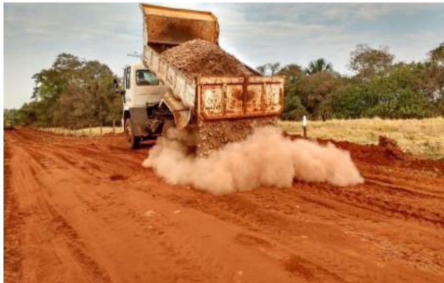
Figura 4 – Equipamentos e Materiais utilizados de RCC
