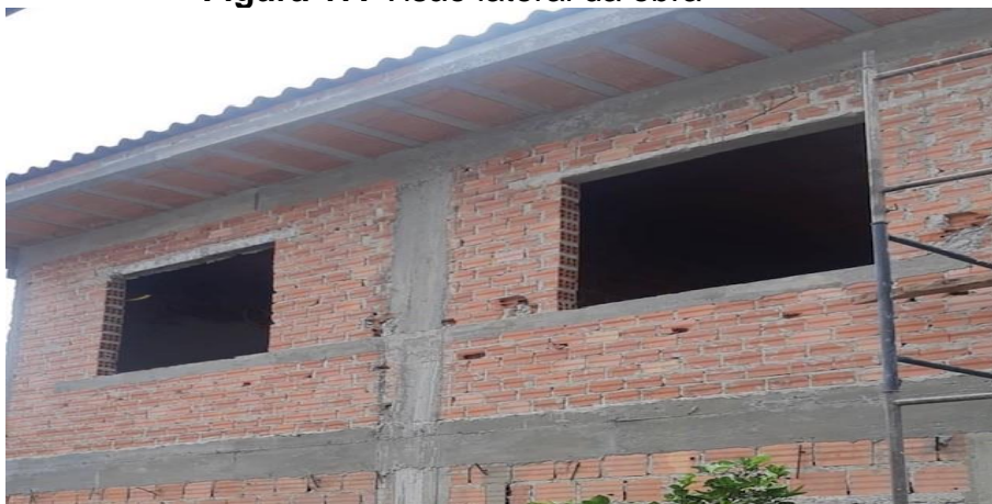
Figura 17: Visão lateral da obra
