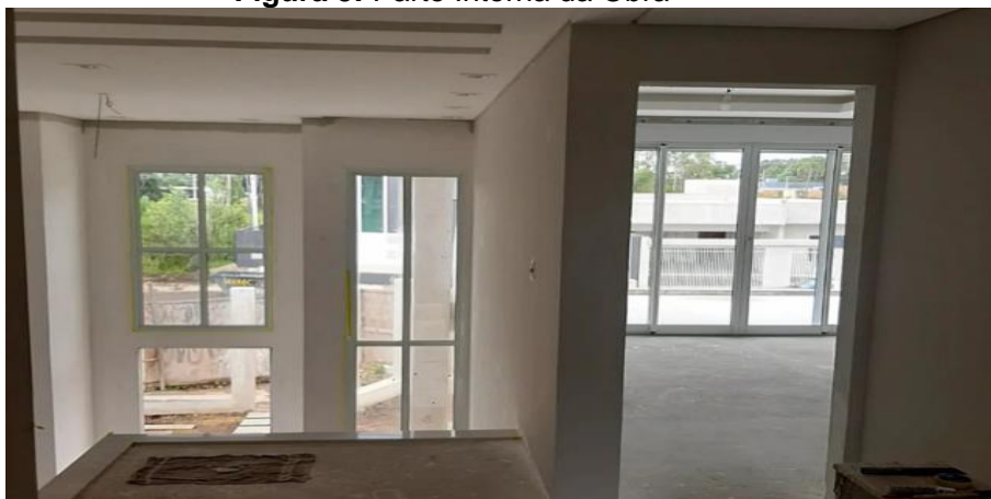
Figura 5: Parte Interna da Obra
