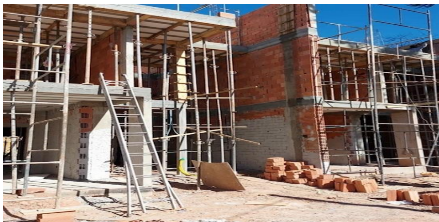
Figura 8: Visão geral da obra
