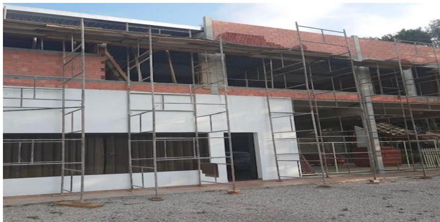
Figura 12: Visão geral da obra
