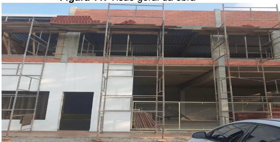
Figura 11: Visão geral da obra
