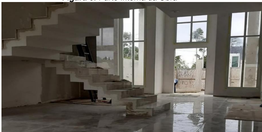
Figura 6: Parte Interna da Obra
