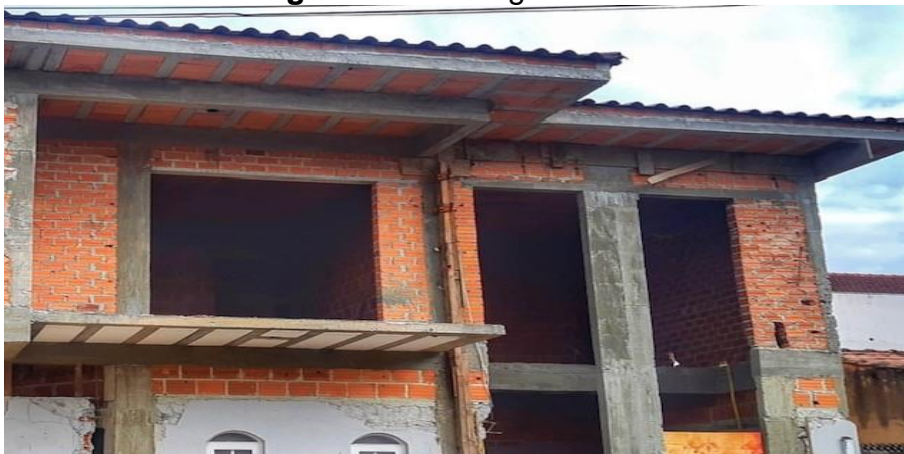
Figura 14: Visão geral da obra
