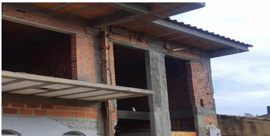
Figura15: Visão geral da obra
