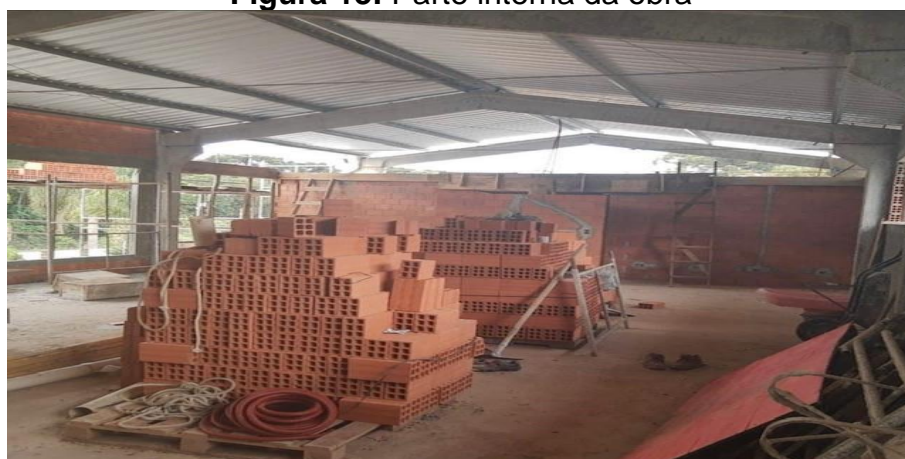
Figura 13: Parte interna da obra
