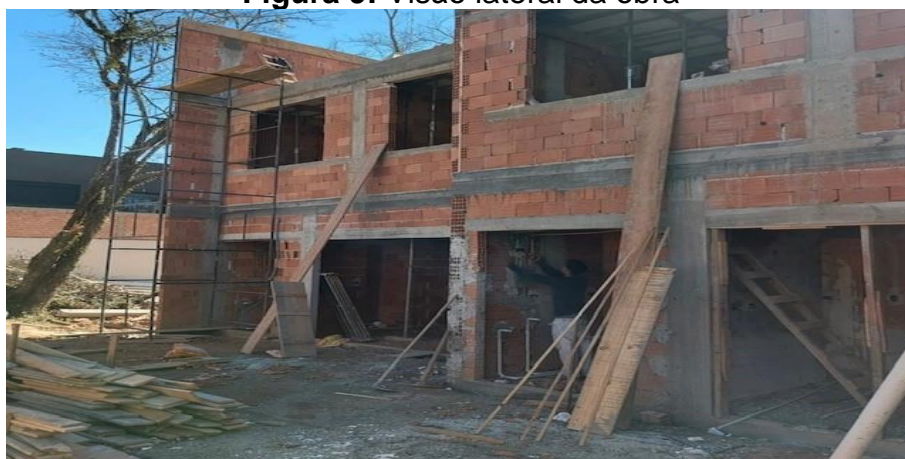
Figura 9: Visão lateral da obra
