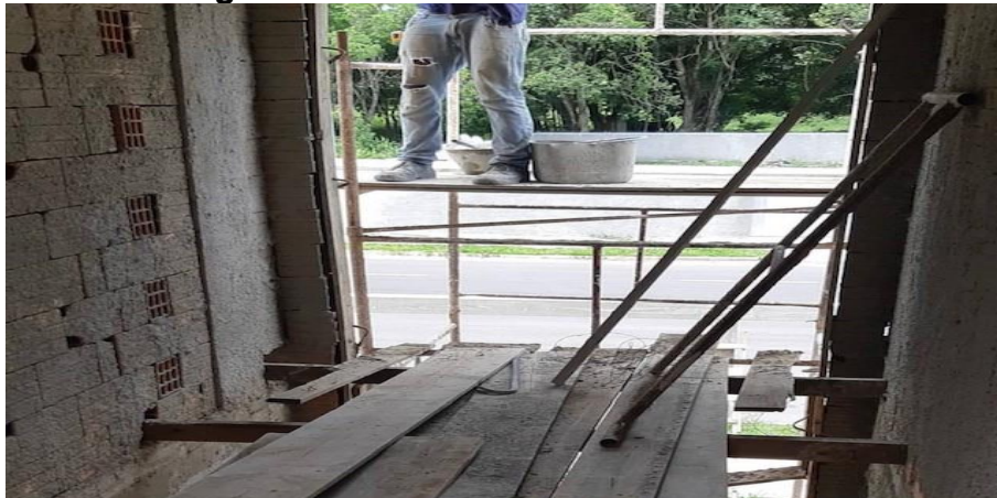
Figura 2: Andaime em não conformidade
