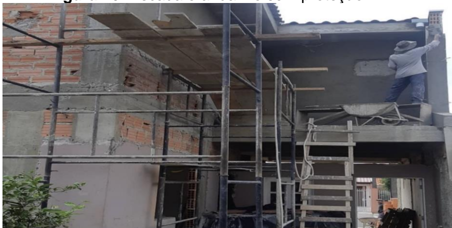
Figura 16: Escada e andaime sem proteção
