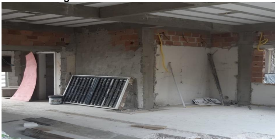
Figura 18: Parte interna da obra
