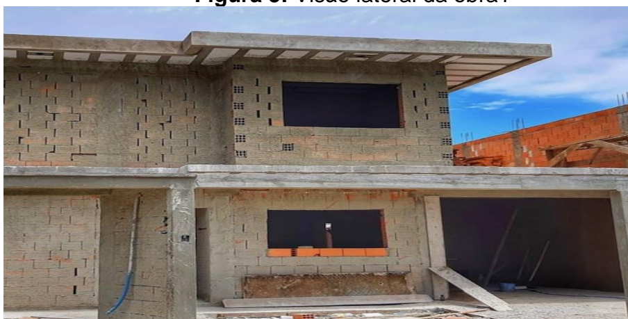
Figura 3: Visão lateral da obra1
