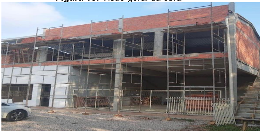
Figura 10: Visão geral da obra
