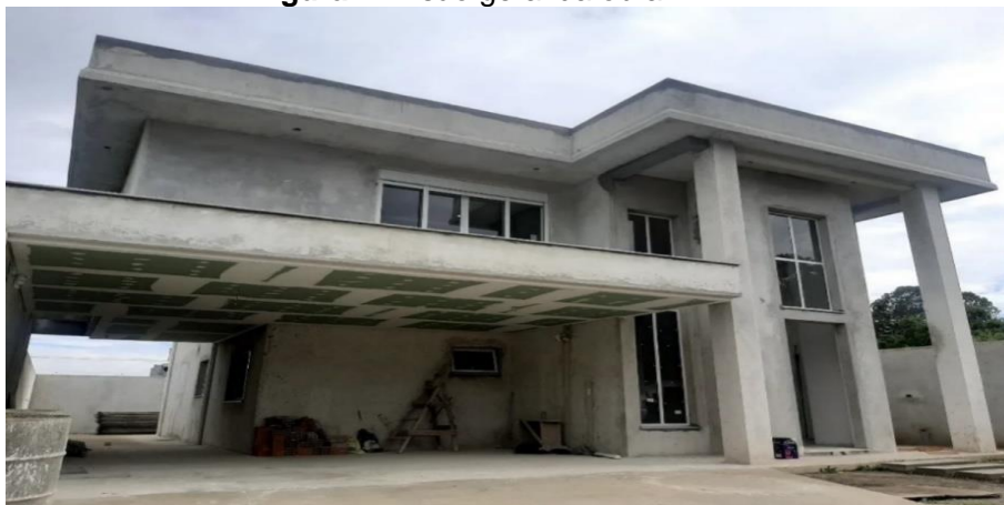
Figura 4: Visão geral da obra
