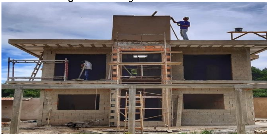
Figura 1: Visão geral da obra
