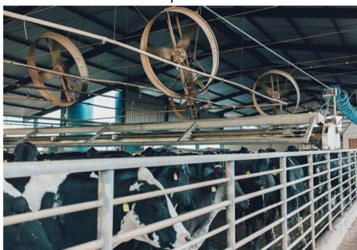
Figura 2 - Ventiladores utilizados em instalação para bovinos de leite para controle de temperatura
