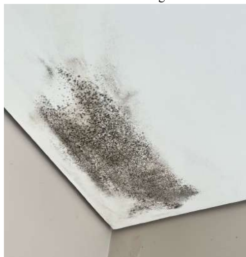
Figura 8: Presença de manchas escuras e mofo em forro de gesso.
