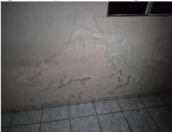
Figura 4: Presença de manchas e mofo em parede.
