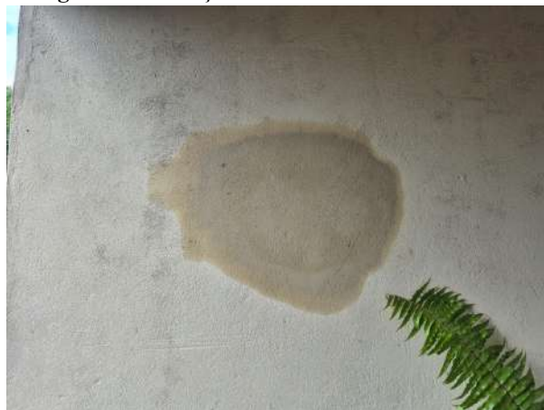
Figura 4: Presença de vazamento hidráulico.
