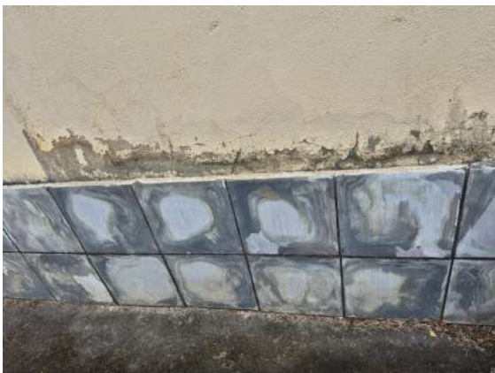
Figura 3: Presença de manchas em revestimento e descascamento de tinta.
