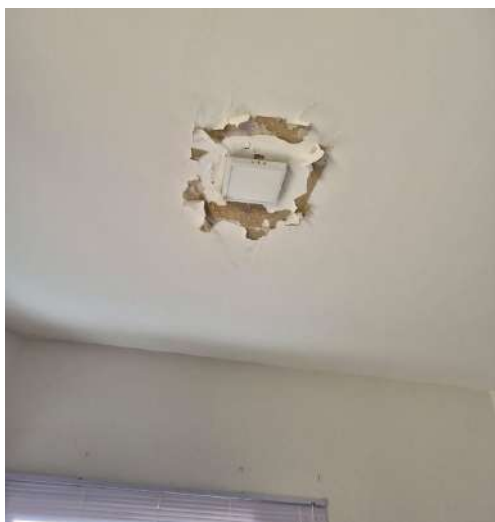
Figura 7: Descascamento de pintura em laje de cobertura.
