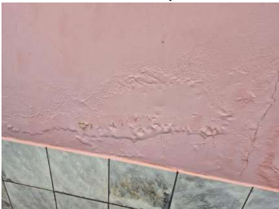
Figura 1: Presença de bolhas na pintura e descascamento na parede.
