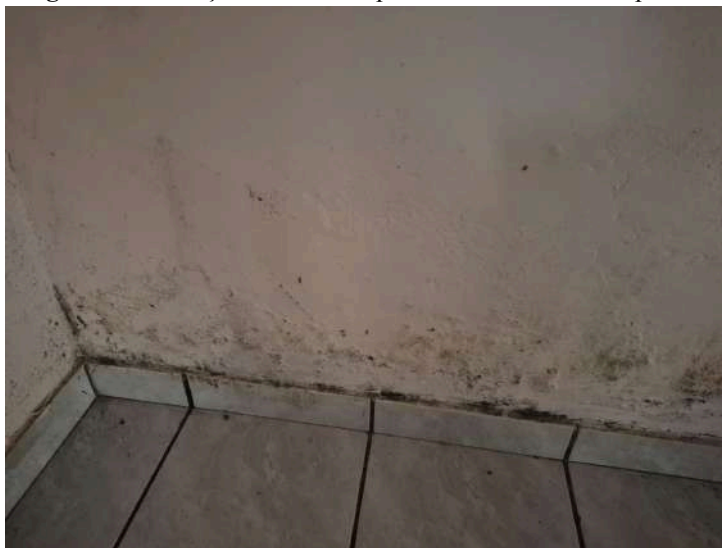
Figura 6: Presença de bolhas na pintura e mofo/bolor na parede.
