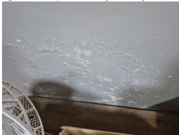
Figura 5: Presença de bolhas na pintura em parede.
