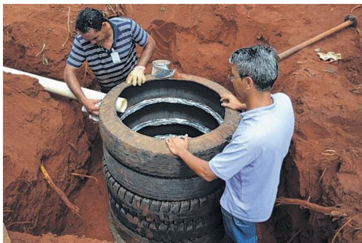
Figura 7 - Fossa séptica com pneus
