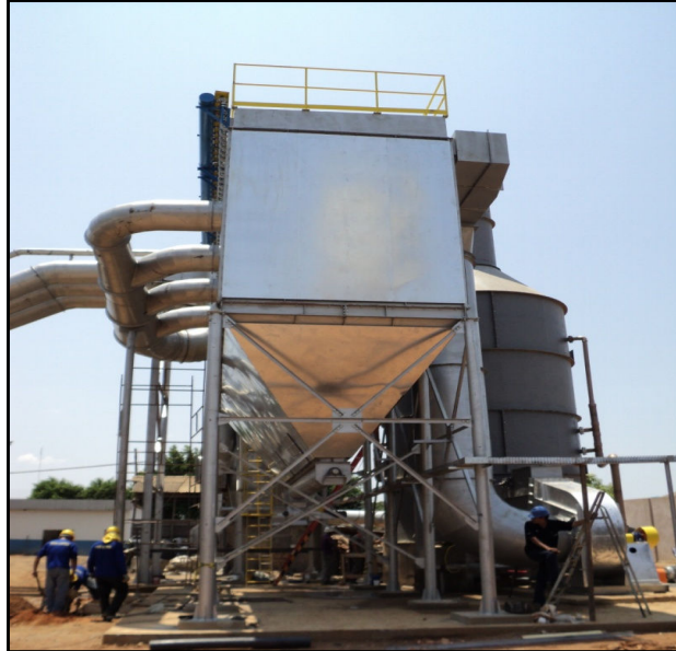
Figura 1 – Sistema de exaustão Fonte: Arquivo pessoal do autor
