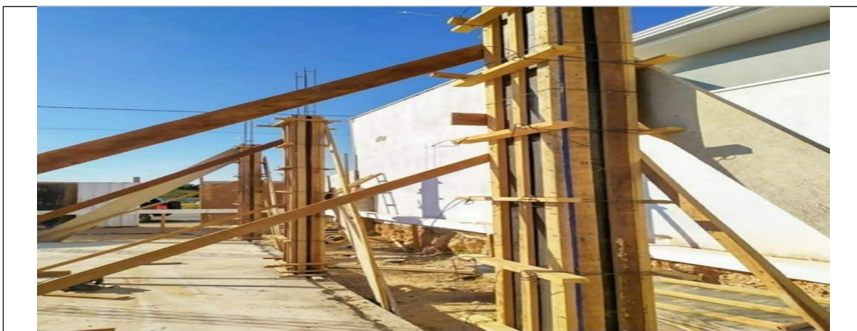
Figura 11 Etapas de construção convencional que mostra o uso excessivo de madeiramento
