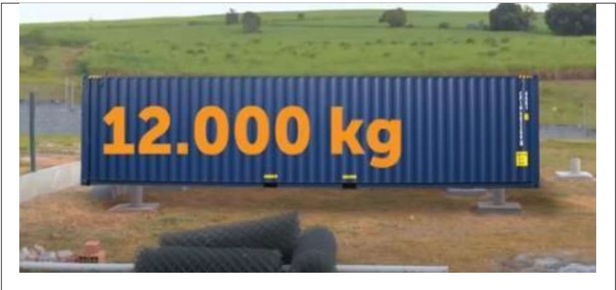
Figura 37 Peso do contêiner com as cargas permanentes e móveis Fonte: Eng. Civil Osmar Martins (2019)
