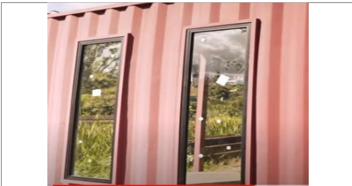
Figura 46 Janelas casa contêiner bem niveladas na construção Contêiner Fonte: Mirian Bolson (2020)
