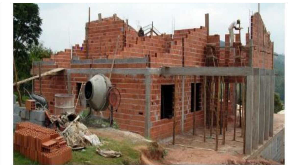
Figura 1 Residência sendo realizada pelo sistema construtivo convencional Fonte: Bellato; Bedin (2018).
