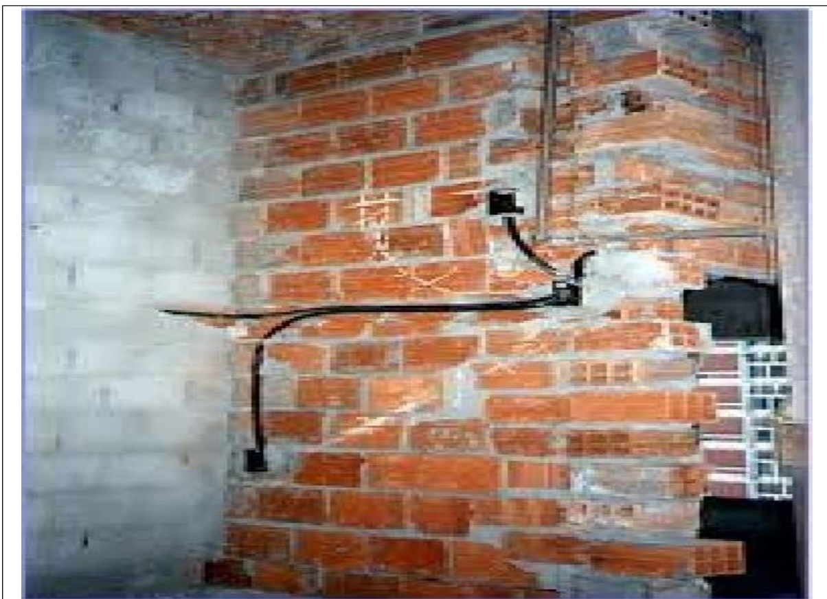
Figura 8 Etapa instalação elétrica de uma construção convencional. Fonte: acabamentos.com 2017
