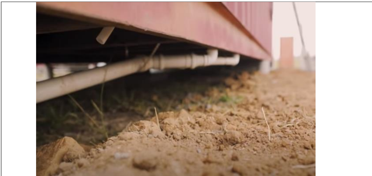
Figura 48 Instalação de esgoto na construção Contêiner Fonte: Mirian Bolson (2020)
