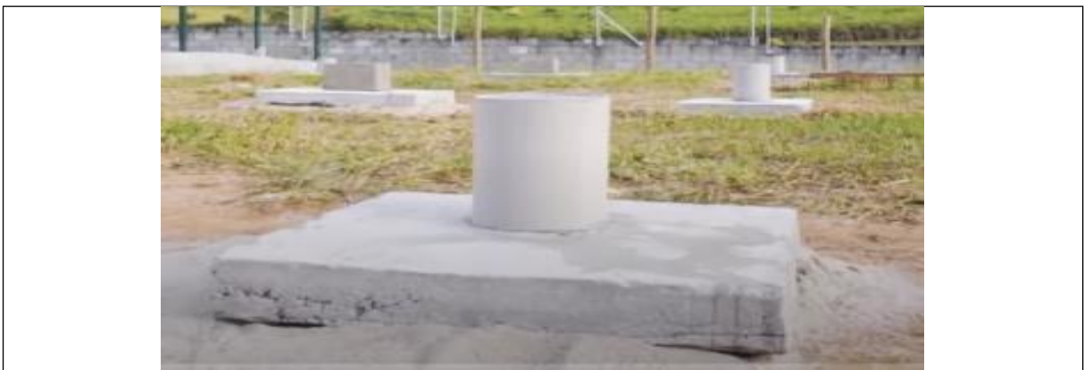
Figura 24 Modelo de apoio de base circular. Fonte: Eng. Civil Osmar Martins (2020)
