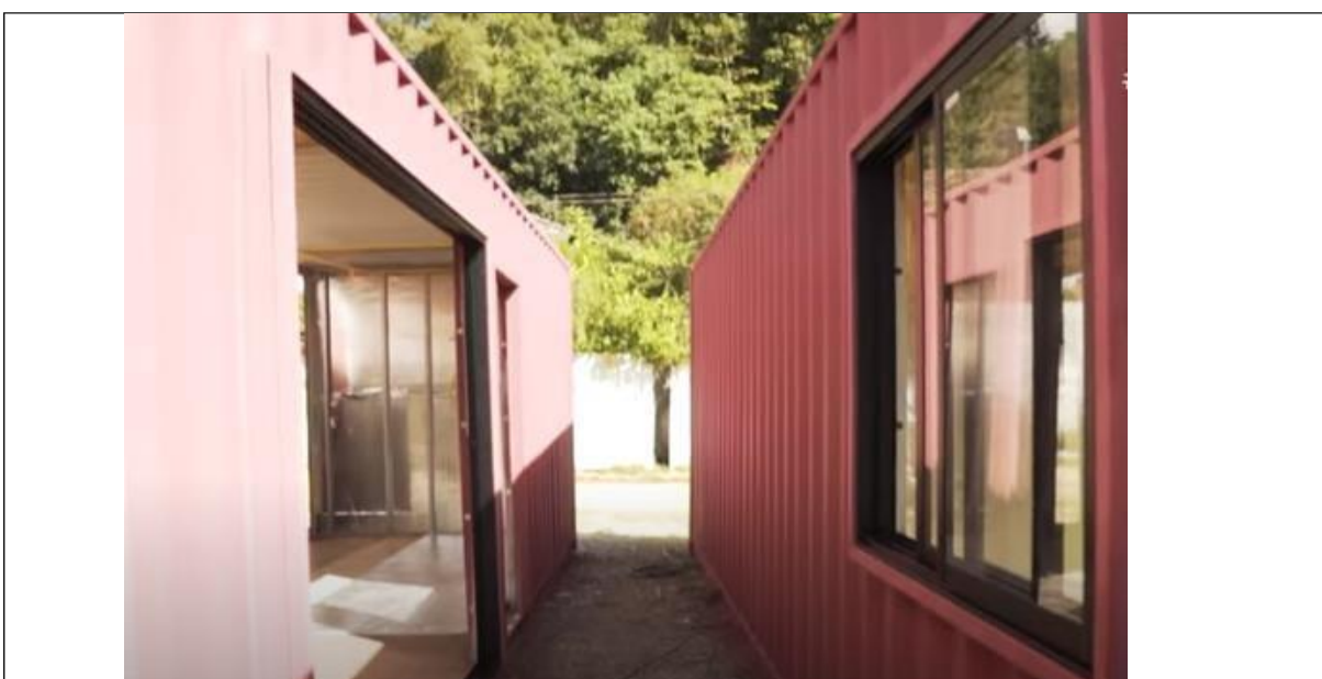
Figura 47 Portas e janelas bem rentes na construção Contêiner Fonte: Mirian Bolson (2020)
