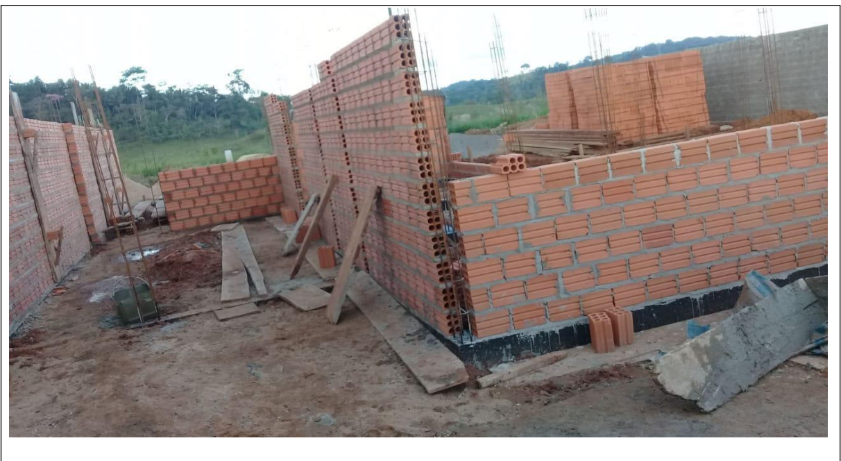
Figura 15 Etapas de construção convencional, paredes de vedação Fonte: Próprio Autor (2020)
