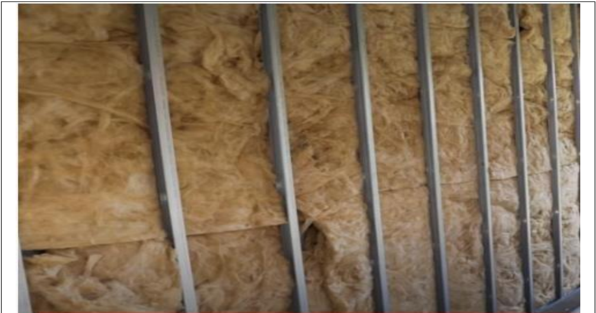
Figura 43 Isolamento térmico e acústico na construção Contêiner na construção Contêiner Fonte: Mirian Bolson (2020)
