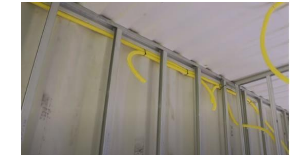
Figura 41 Passagem dos conduites na construção Contêiner Fonte: Mirian Bolson (2020)
