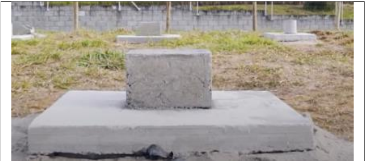
Figura 23 Modelo de apoio de base retangular. Fonte: Eng. Civil Osmar Martins (2020)
