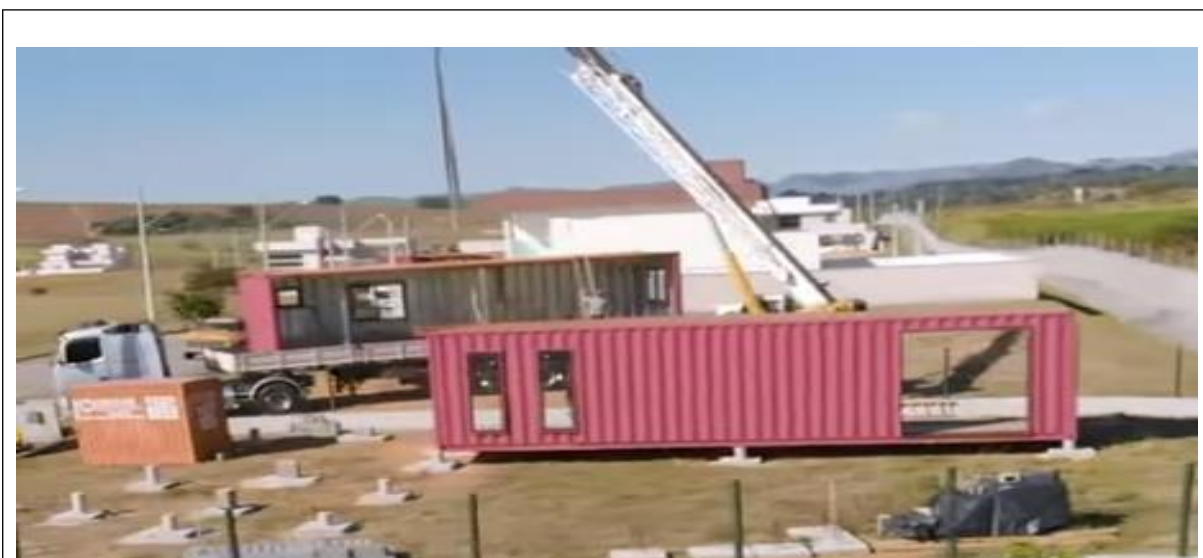
Figura 39 Retirada do contêiner com o auxílio de guindaste Fonte: Mirian Bolson (2020)
