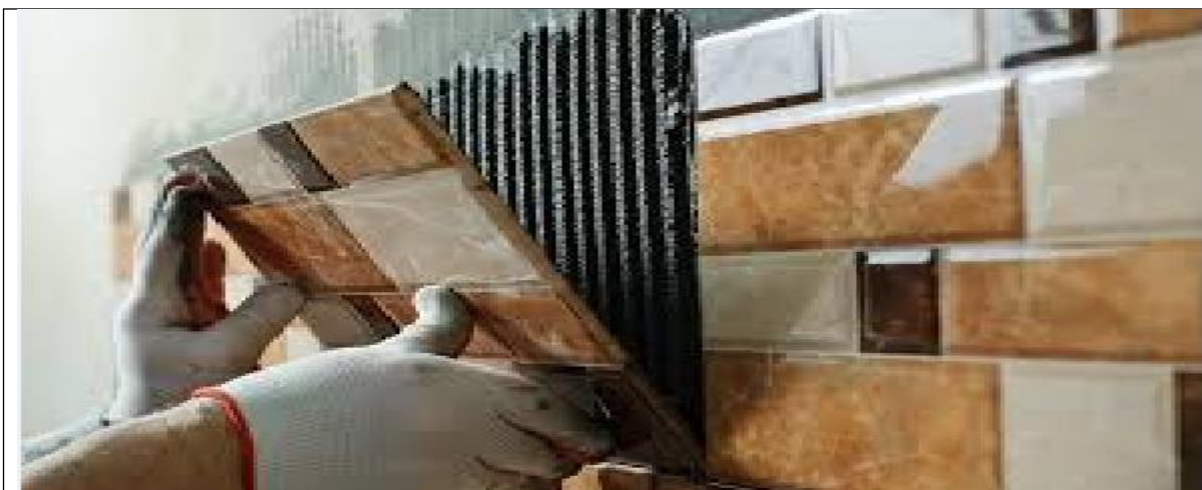
Figura 6 Execução de revestimento Fonte: revestimento cerâmicos 2019
