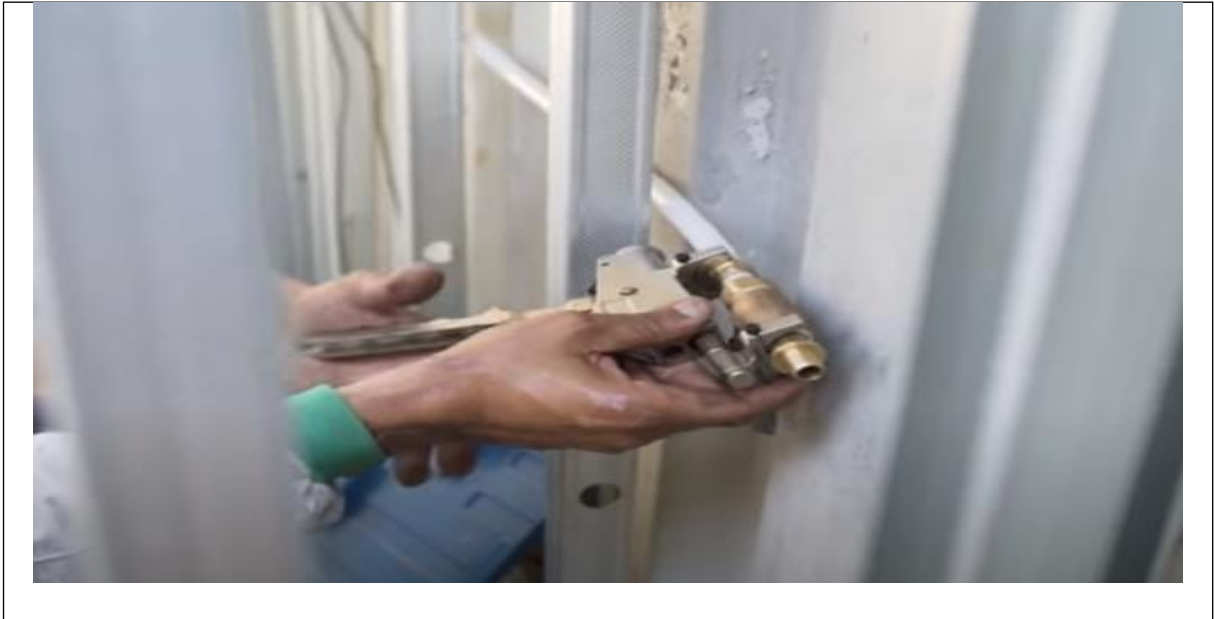
Figura 42 Instalação hidráulica na construção Contêiner Fonte: Mirian Bolson (2020)
