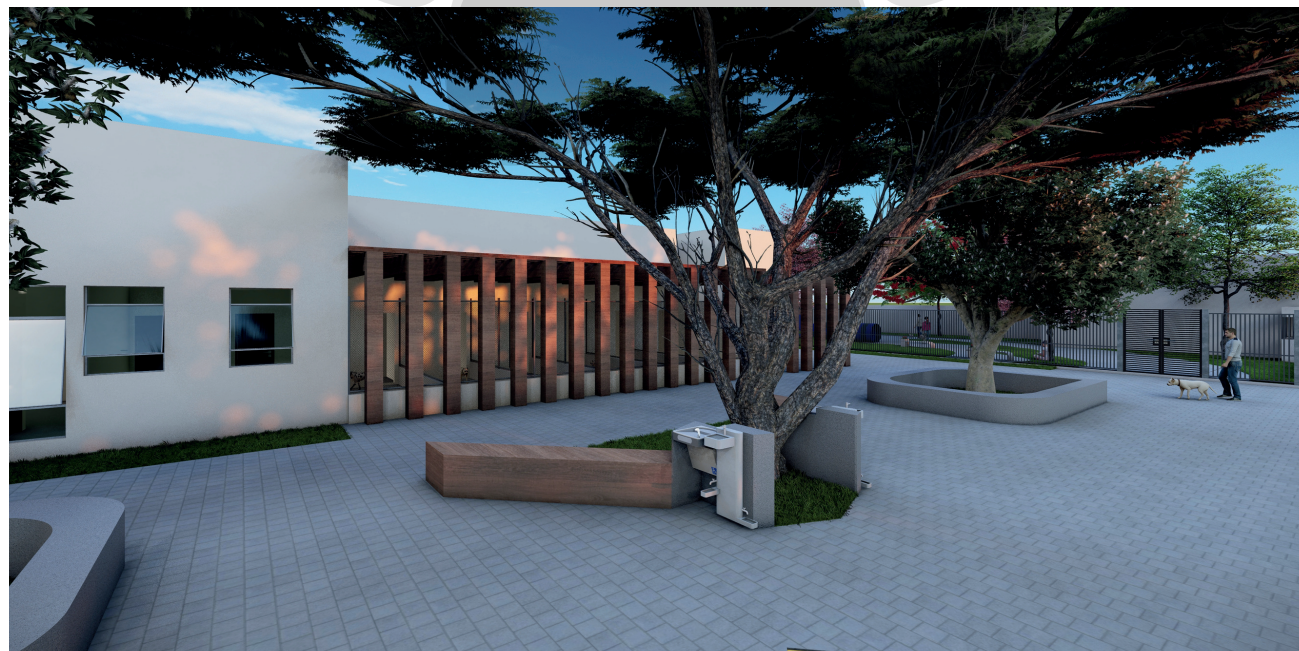
Vista externa do canil, foi utilizado brises para proteção e conforto em relação ao sol.
