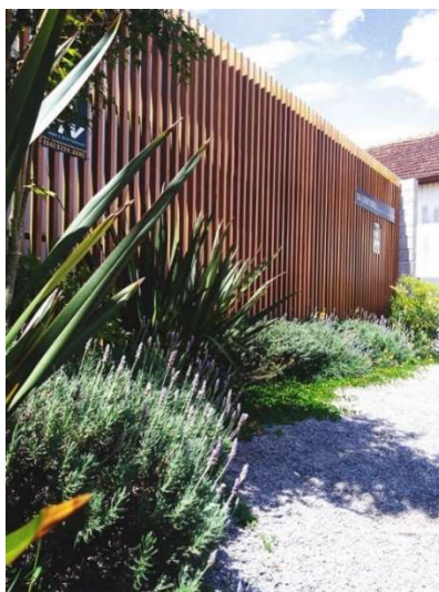
Figura 14 – Brises na fachada principal.
