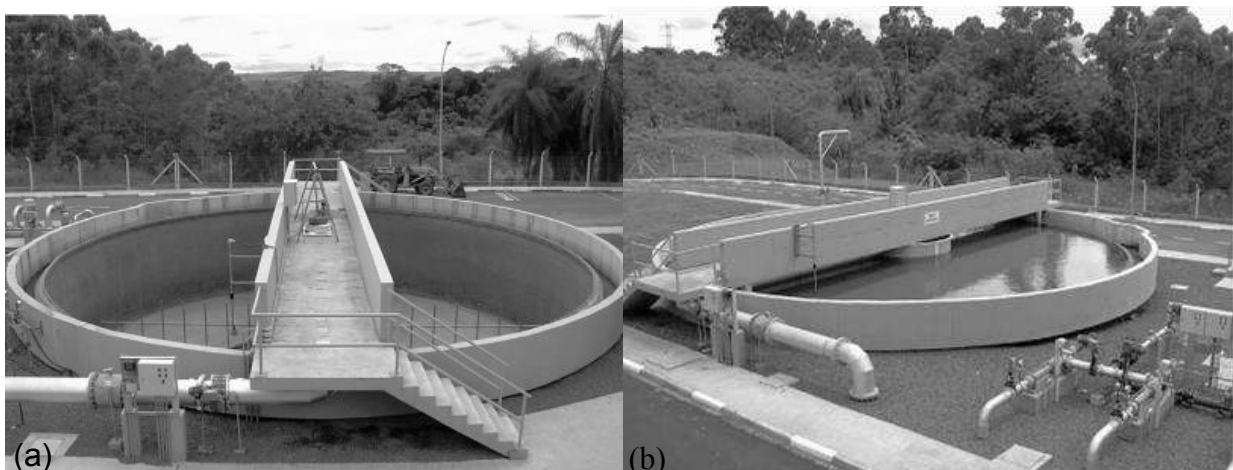
Figura 6. Adensadores por gravidade. (a) Vazio. (b) Em operação
