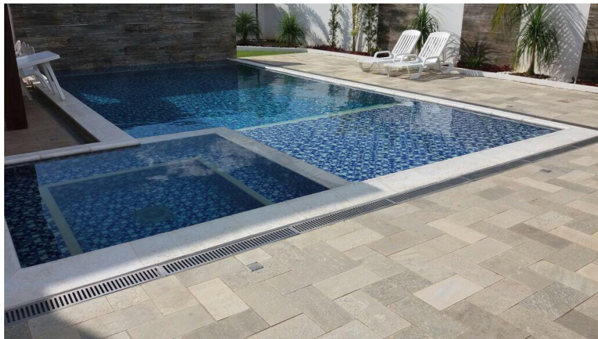
Figura 24 - PISCINA 12 – Nenhuma patologia encontrada
