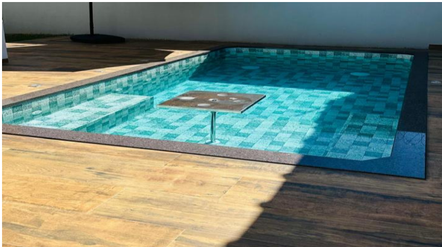
Figura 18 - PISCINA 6 – Nenhuma patologia encontrada
