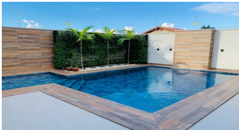
Figura 25 - PISCINA 13 – Nenhuma patologia encontrada
