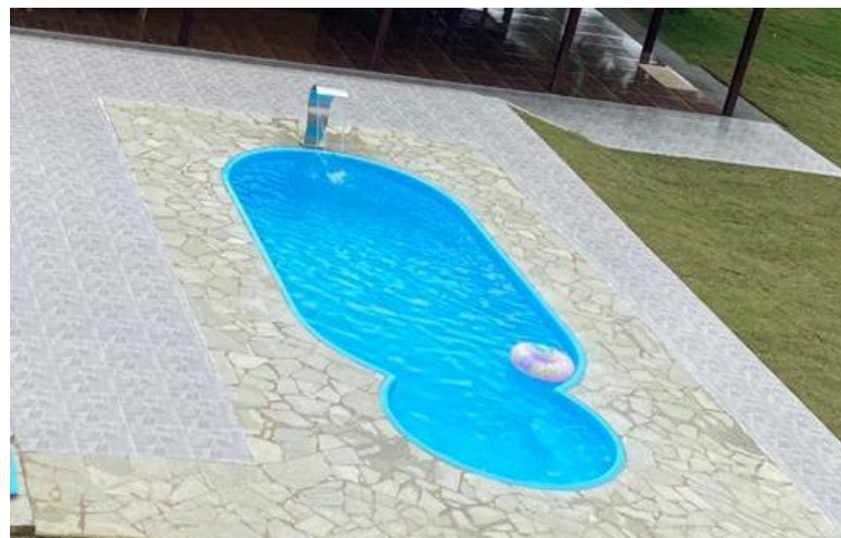
Figura 31 - PISCINA 19 – Nenhuma patologia encontrada
