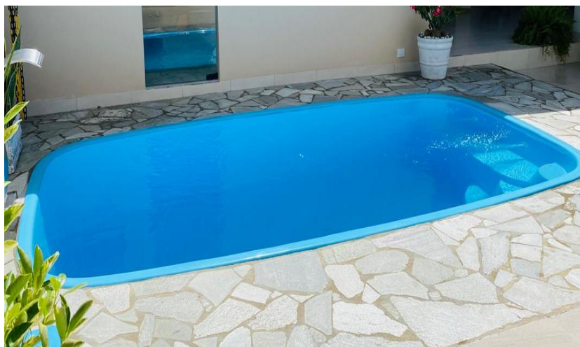
Figura 28 - PISCINA 16 – Nenhuma patologia encontrada
