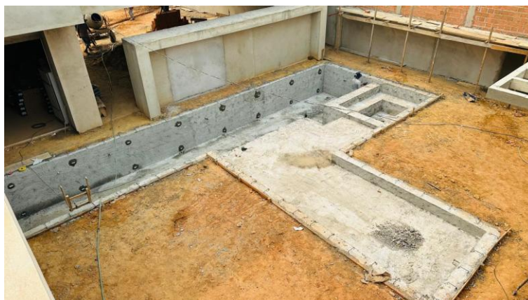
Figura 8 - Impermeabilização da parede da piscina
