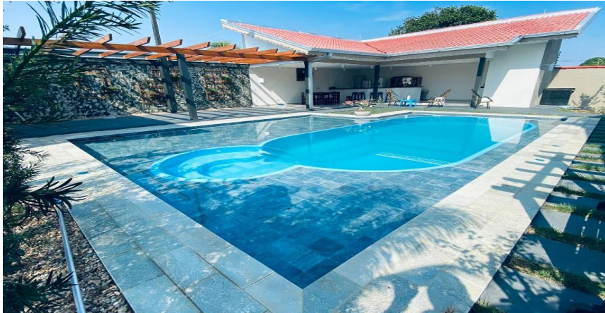
Figura 29 - PISCINA 17 – Nenhuma patologia encontrada
