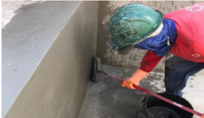
Figura 9 - Aplicação de impermeabilizante a base de cimento polimérico
