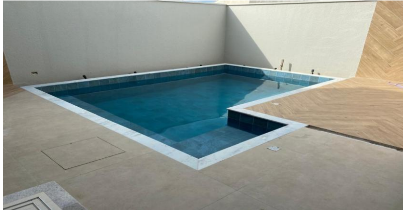
Figura 26 - PISCINA 14 – Nenhuma patologia encontrada
