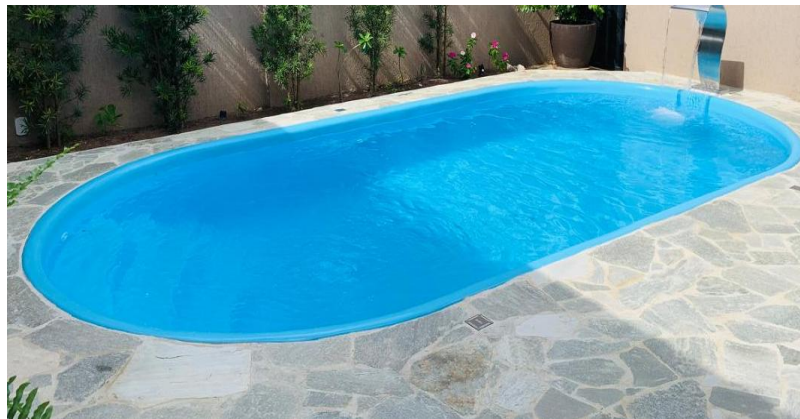
Figura 30 - PISCINA 18 – Nenhuma patologia encontrada
