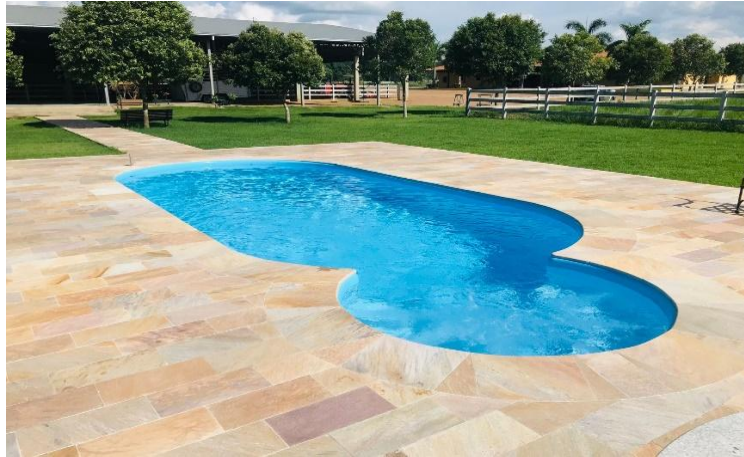
Figura 32 - PISCINA 20 – Nenhuma patologia encontrada
