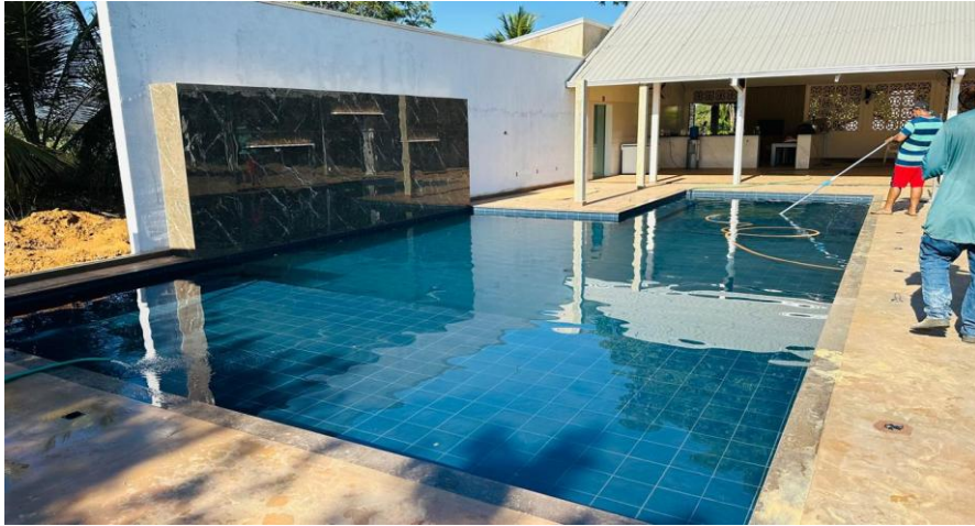
Figura 17 - PISCINA 5 - Nenhuma patologia encontrada
