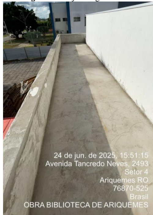
Imagem 11 – Lajes e vigas Biblioteca.
