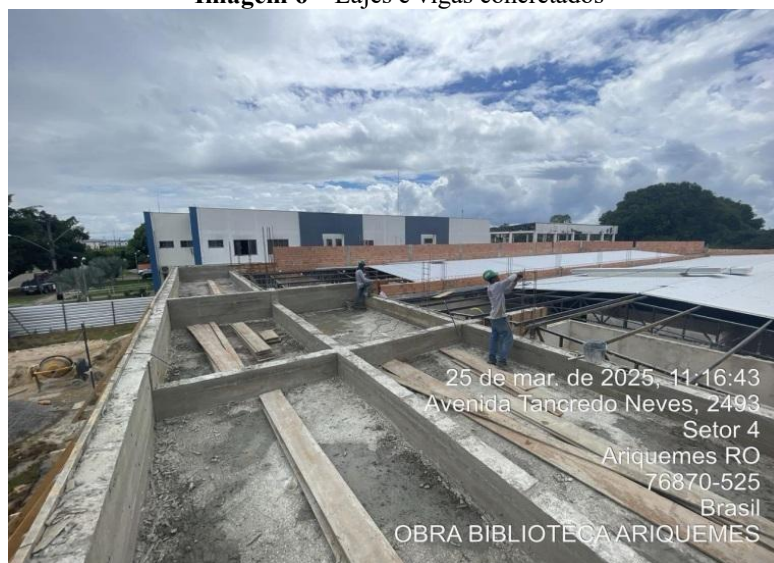
Imagem 6 – Lajes e vigas concretados
