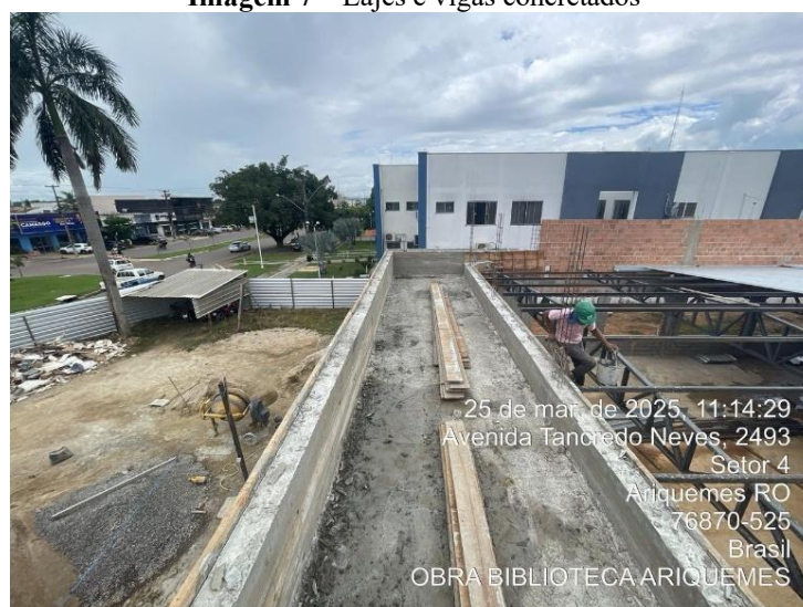
Imagem 7 – Lajes e vigas concretados
