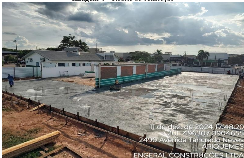
Imagem 4 – Radier da edificação
