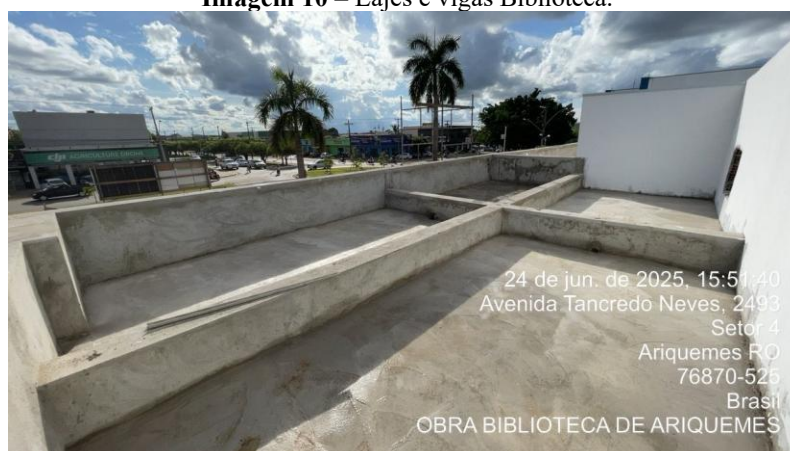
Imagem 10 – Lajes e vigas Biblioteca.
