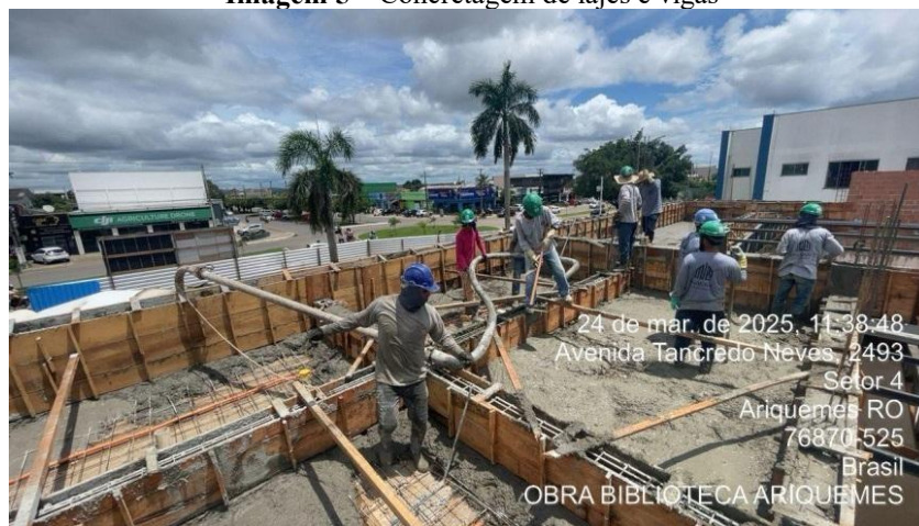
Imagem 5 – Concretagem de lajes e vigas
