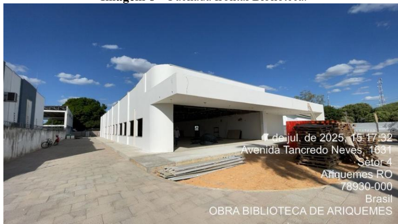
Imagem 8 – Fachada frontal Biblioteca.
