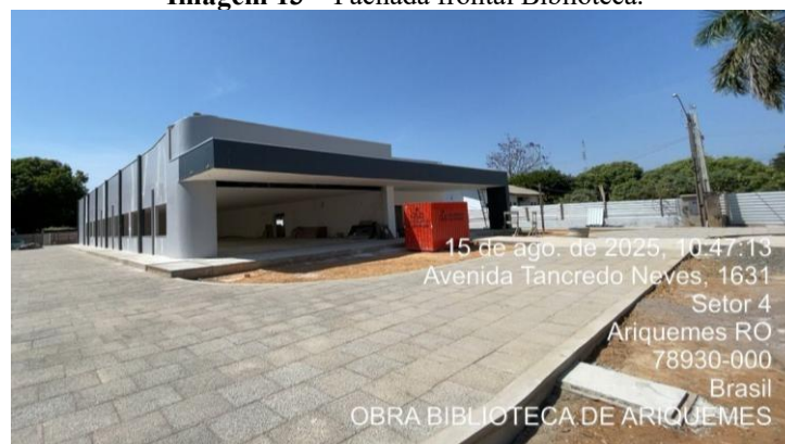
Imagem 13 – Fachada frontal Biblioteca.
