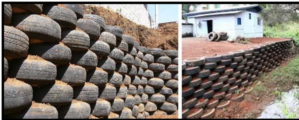
Imagem 02- Contenção de erosão do solo
