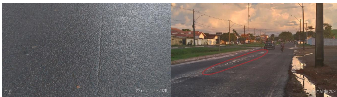
Figura 16 – Fissuras longitudinais.
