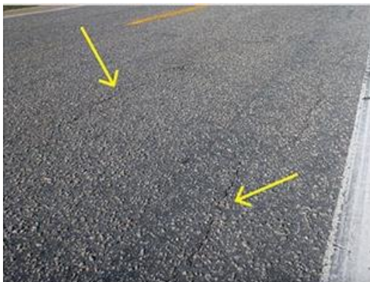
Figura 1 - Fissuras
