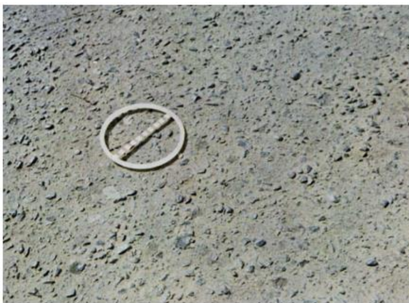
Figura 8 - Desgaste
