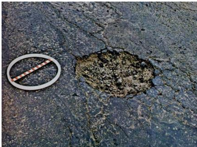
Figura 6 - Panela ou Buraco
