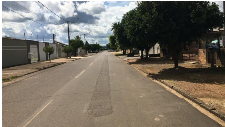
Figura 11 - Início da Rua Rio de Janeiro, sentido Av. Tabapuã
