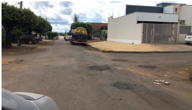
Figura 21 - Meio da Rua Porto Alegre, sentido Av. Tabapuã
