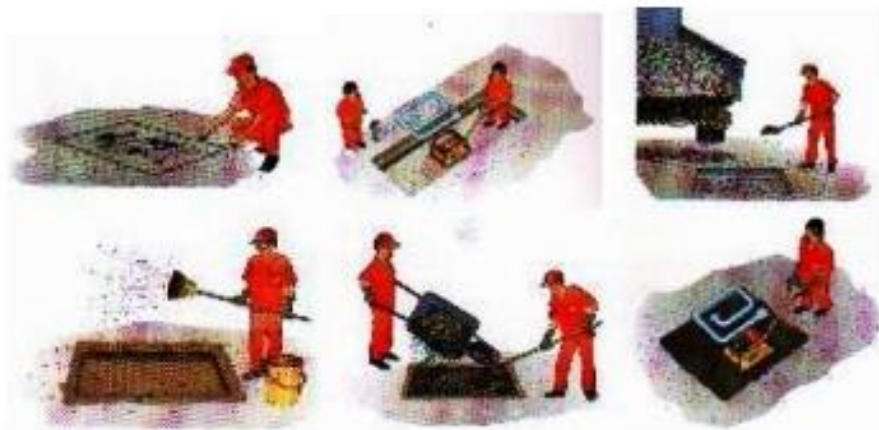
Figura 63 - Processo de recuperação do buraco
