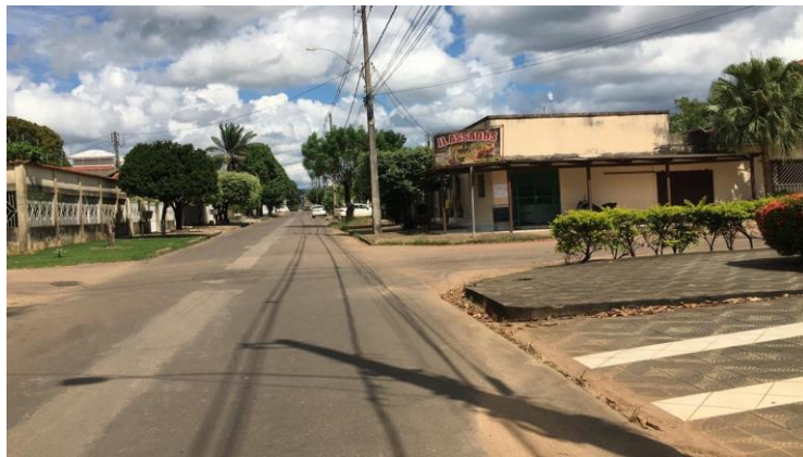
Figura 9 - Meio da Rua Vitória, sentido Av. Canaã
