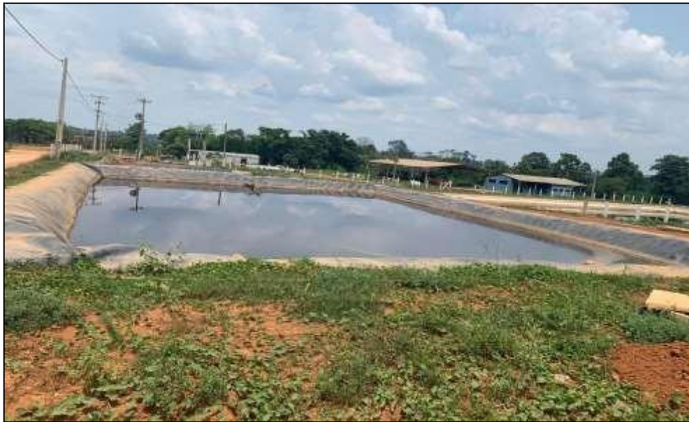
Figura 7 – Lagoa anaeróbia das células abertas do aterro sanitário
