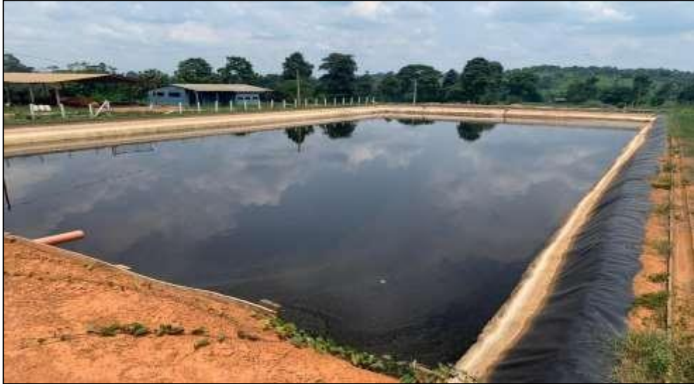
Figura 9 – Lagoa facultativa do sistema de lagoas do aterro sanitário
