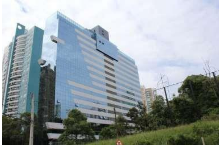
Figura 18 - Edifício Eurobusiness - PR
