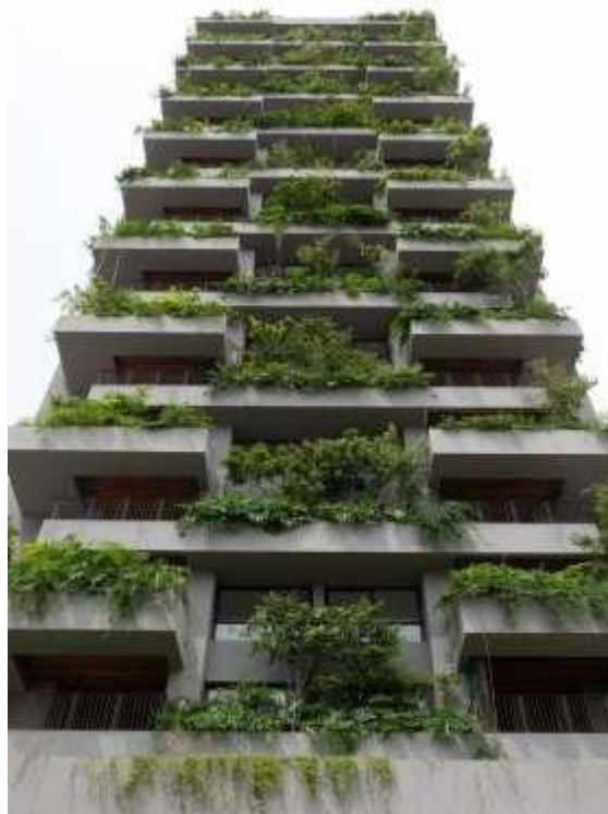
Figura 15 - Fachada do Edifício Seed
