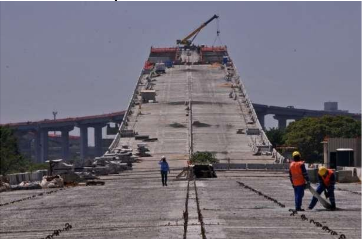
Figura 12 - Obras da Ponte Guaíba – RS
