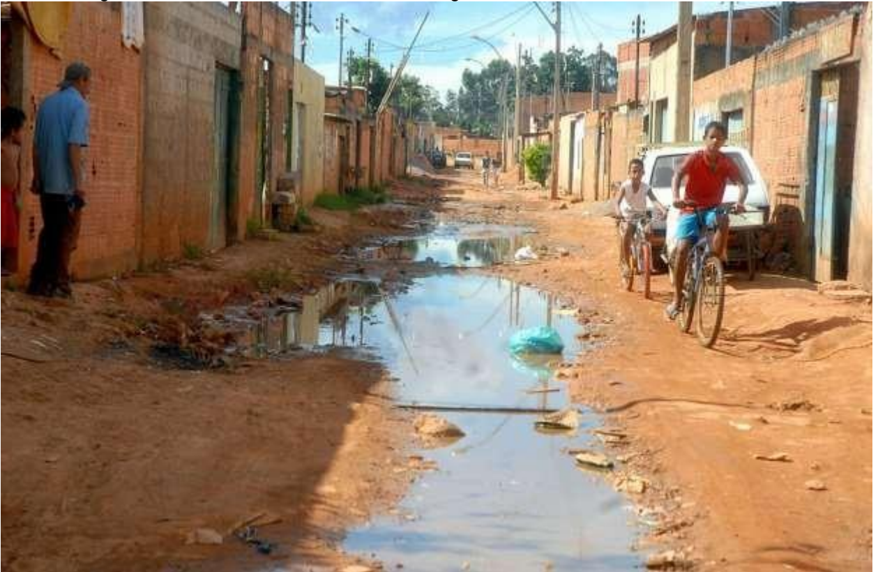
Figura 11 - Falta de Saneamento Básico e Água tratada em Subúrbios e Periferias
