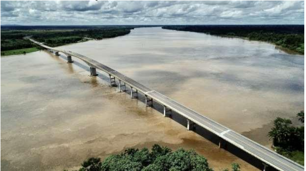
Figura 13 - Obras da Ponte Guaíba – RS
