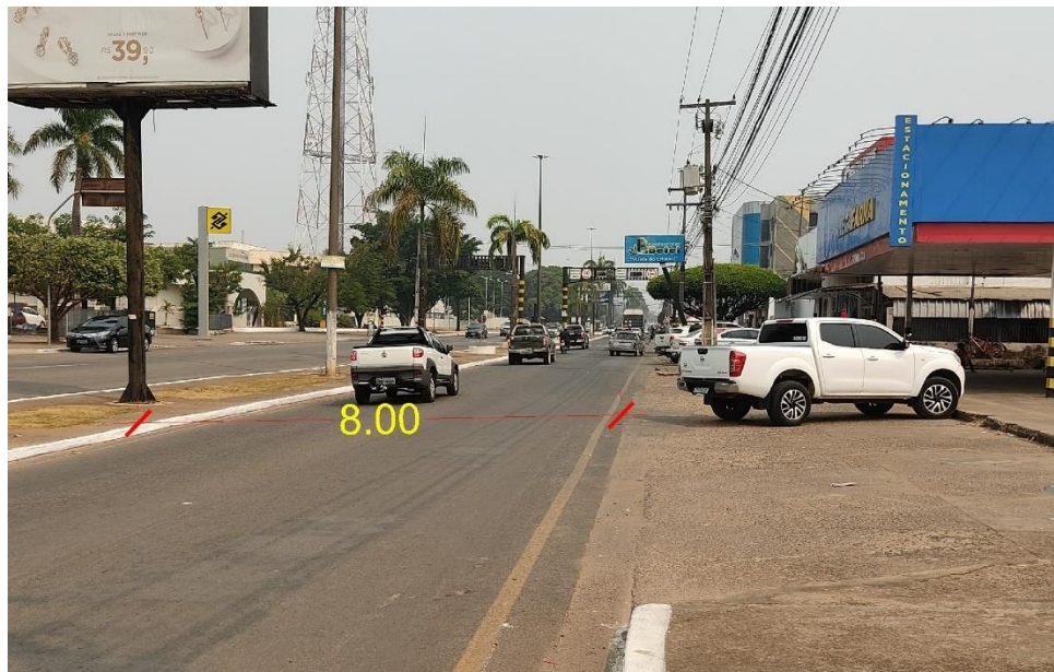
Figura 6: Pavimento a direita do canteiro central
