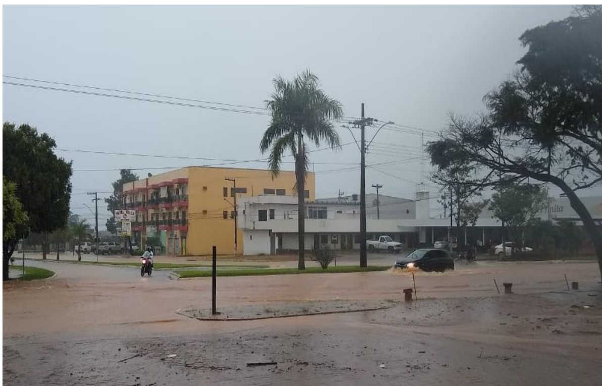
Figura 8 - Trechos críticos de acúmulo de águas na Avenida próxima a avenida Tancredo Neves
