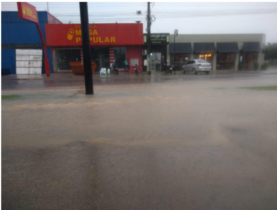
Figura 9 - Trechos críticos de acúmulo de águas Avenida Tancredo
