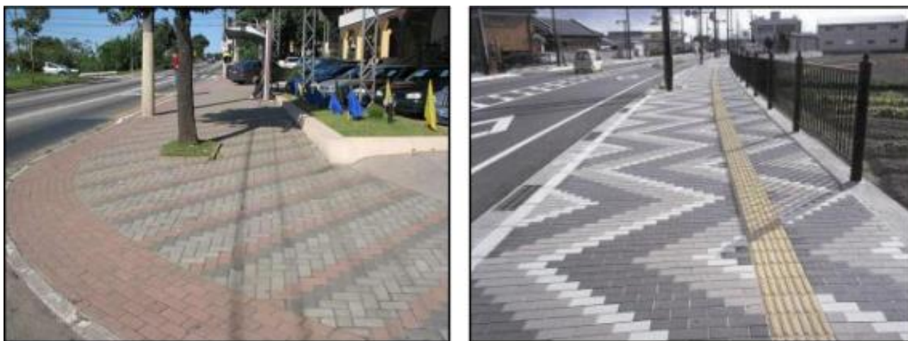
Figura 15 - Tipo de Pavimento em Paver.
