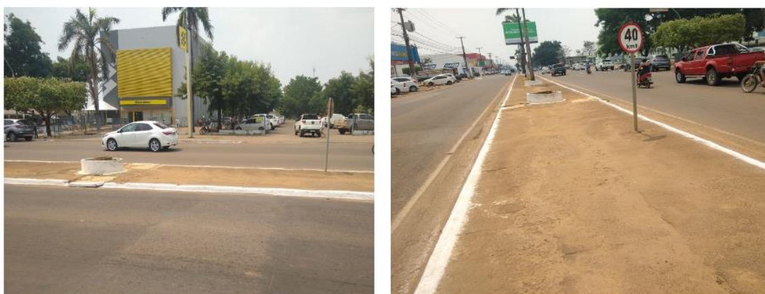
Figura 14 - Canteiro Central da Avenida Tancredo Neves.
