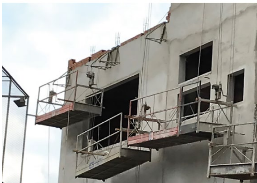
Figura 2 – Andaimos suspensos fixados na estrutura da edificação com emprego de afastadores metálicos e cabos de aço
