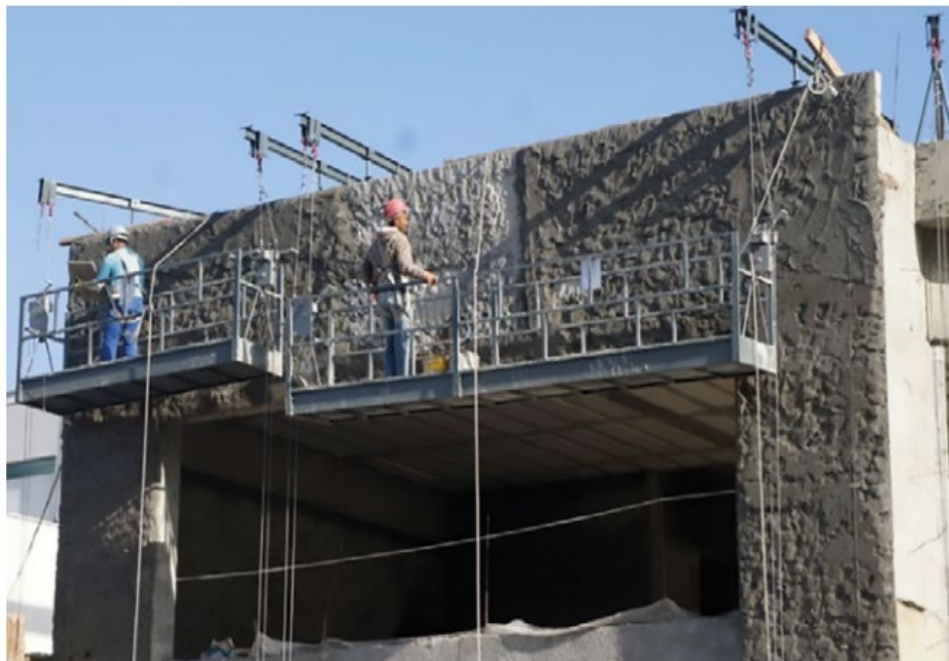
Figura 1 – Andaimos suspensos fixados na estrutura da edificação com emprego de vigas metálicas com perfil I e cabos de aço
