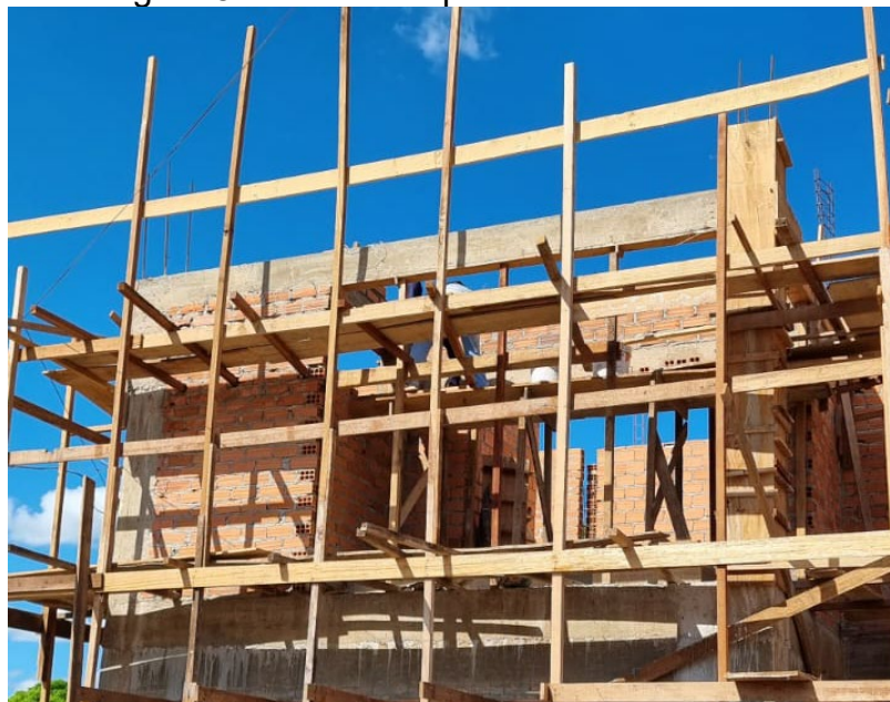
Figura 8 – Andaime apoiado em madeiras
