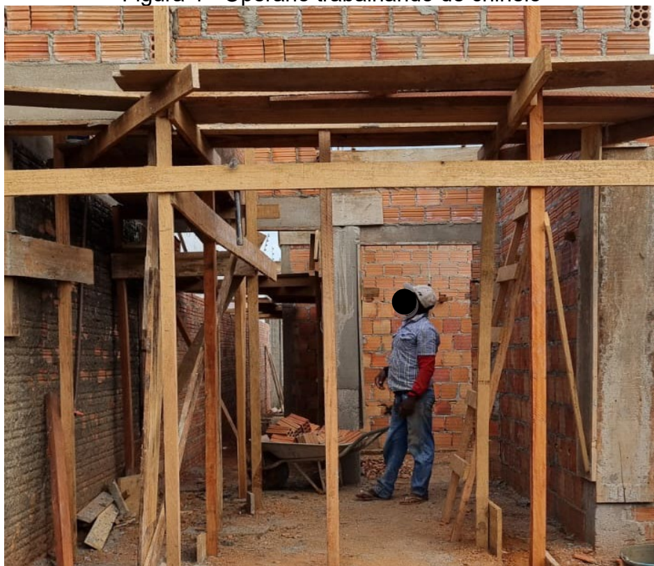
Figura 4 - Operário trabalhando de chinelo
