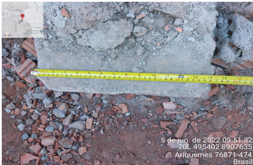
Figura 14: Sapata S10 com dimensão de 30x36cm.
