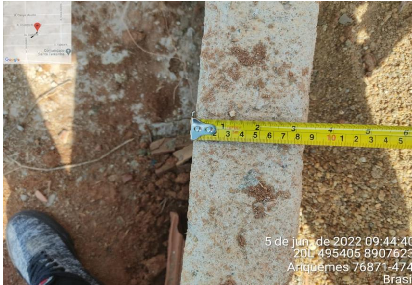
Figura 20: Viga baldrame da entrada garagem.
