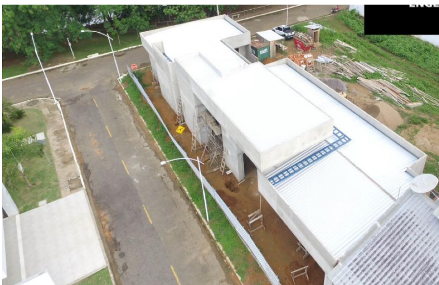
Figura 3: Fase final da obra
