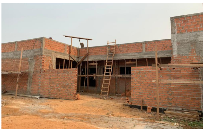
Figura 2: Processo de obra
