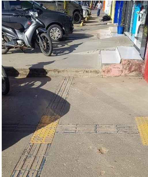
Figura 17 – Desnível e inclinação
