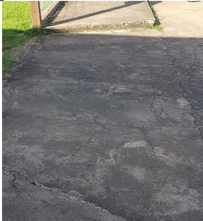
Figura 18 – Desnível entre a entrada para automóveis
