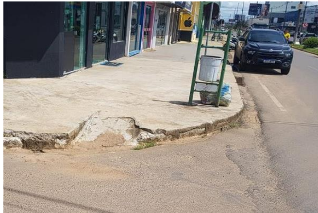
Figura 13 – Rampa danificada
