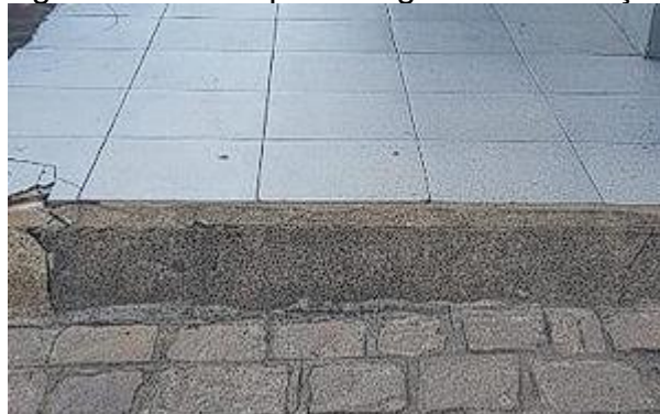
Figura 15 – Rampa com grande inclinação
