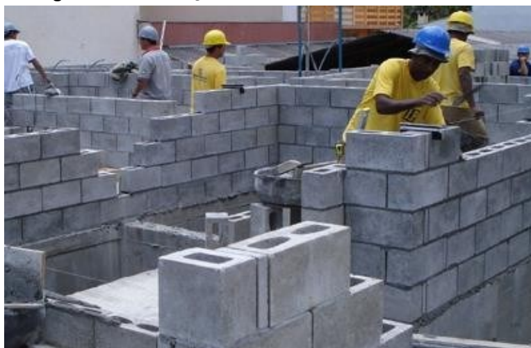
Figura 21 – Execução de alvenaria estrutural
