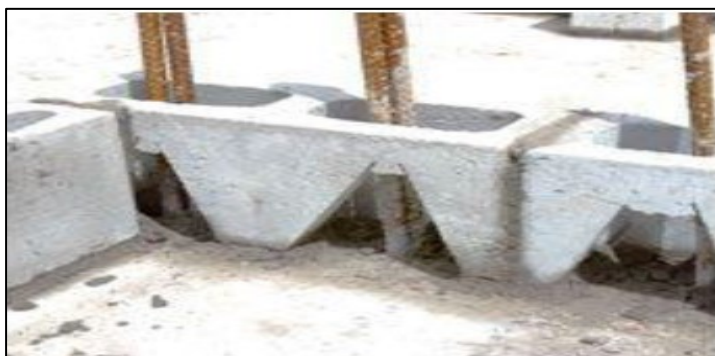
Figura 22. Blocos grauteados atravessados por ferragens
