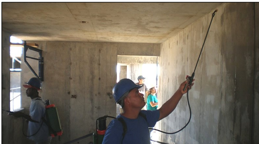
Figura 17. Cura por irrigação ou aspersão de água
