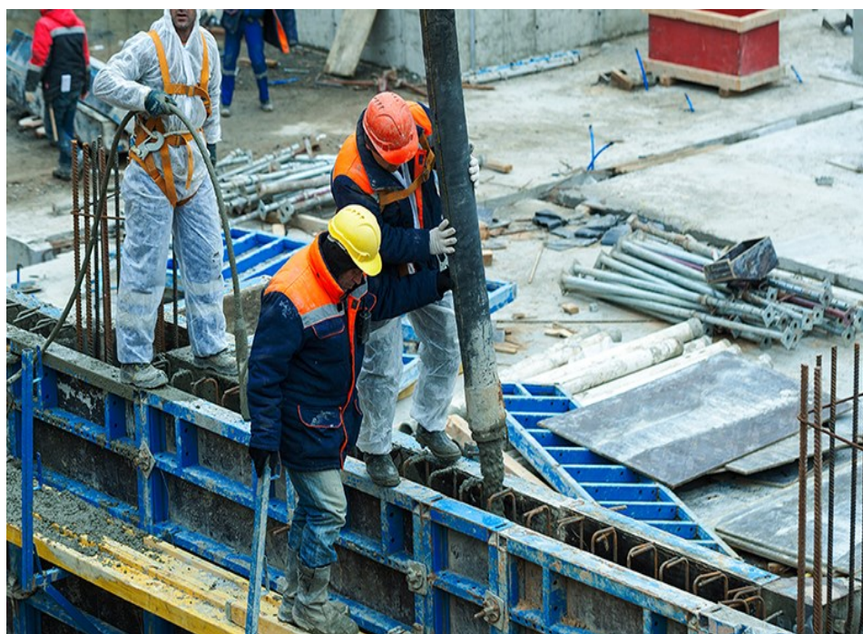
Figura 10. Aplicação do concreto
