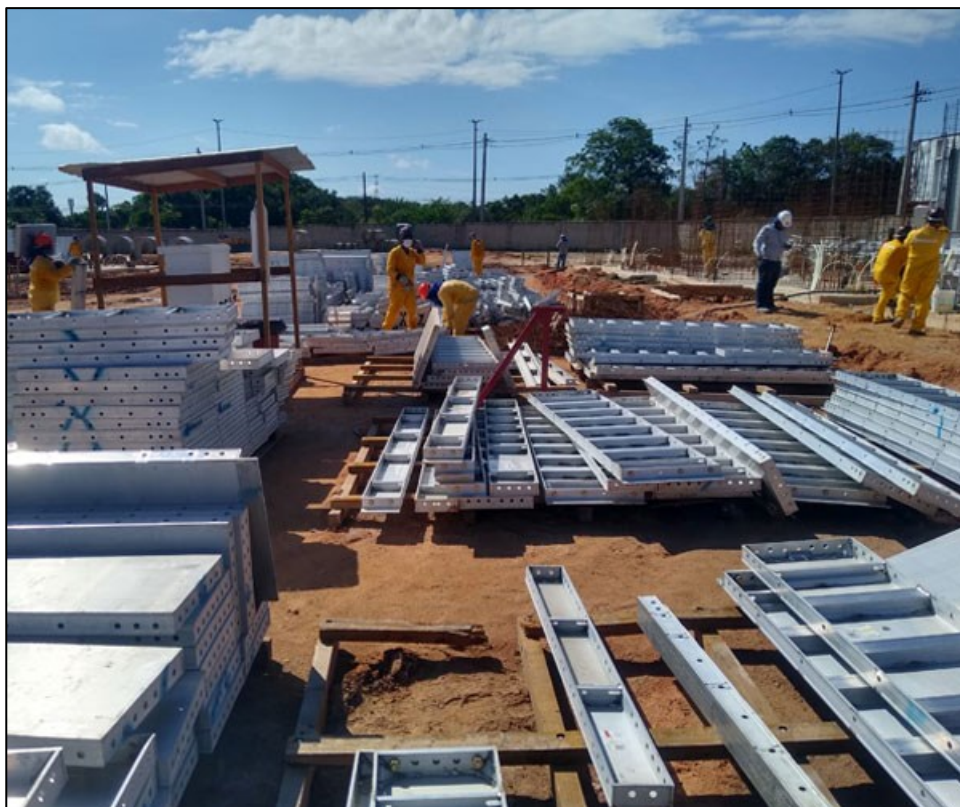
Figura 9 – Limpeza das peças após a desforma
