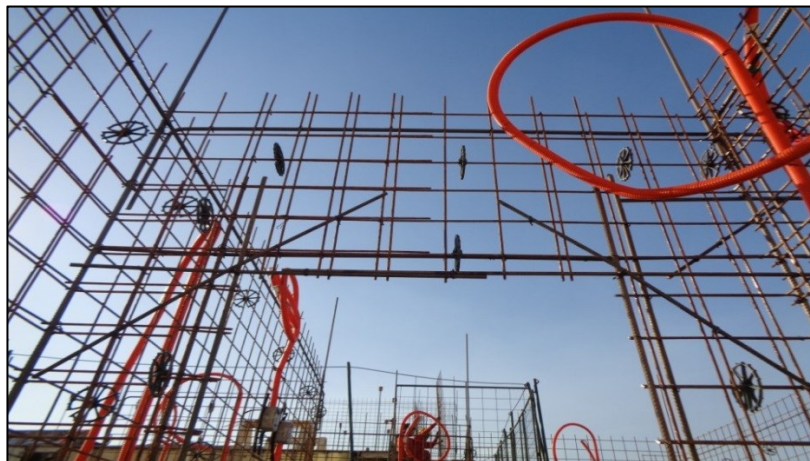
Figura 3. Armadura de reforço
