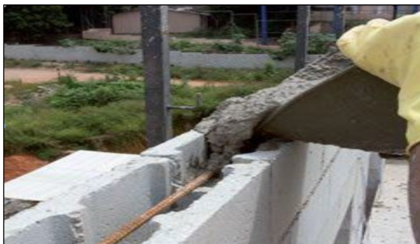
Figura 25. Grauteamento das canaletas
