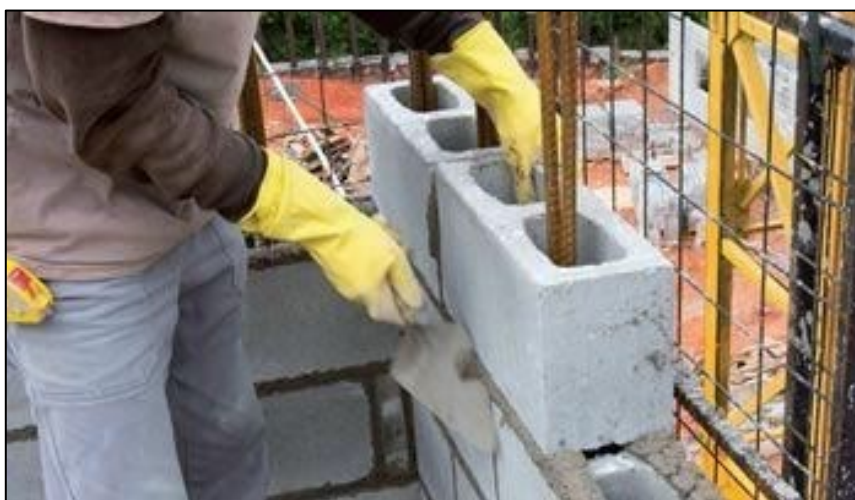
Figura 23. Barras de aço passando pelos blocos
