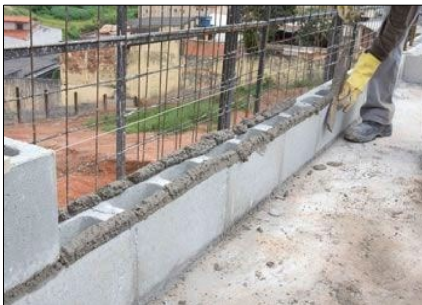
Figura 24 – Camada de argamassa entre os blocos
