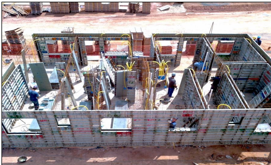
Figura 8. Montagem dos painéis externos e internos
