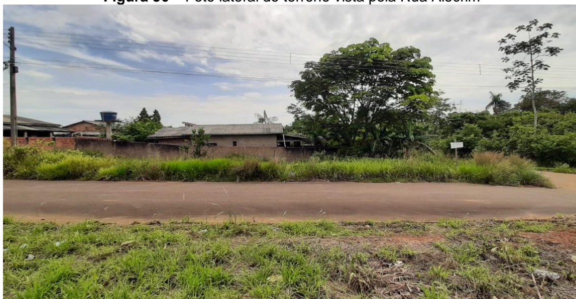
Figura 36 – Foto lateral do terreno vista pela Rua Alecrim
