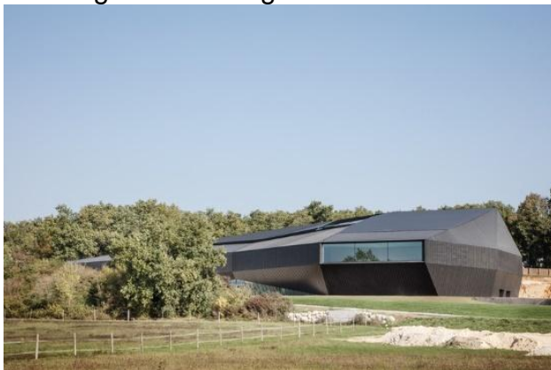
Figura 20– Imagens da fachada
