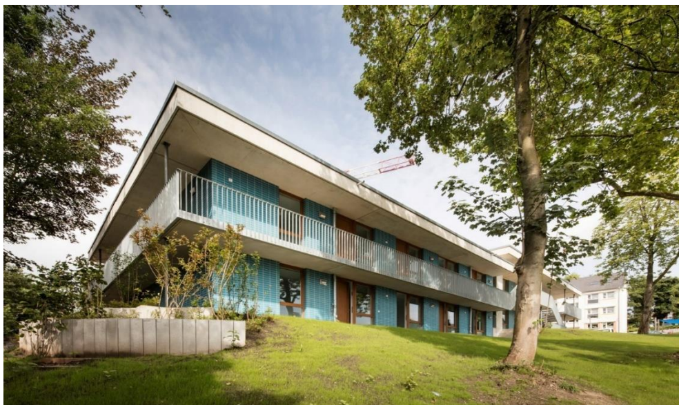
Figura 7 - Três edifícios paralelos
