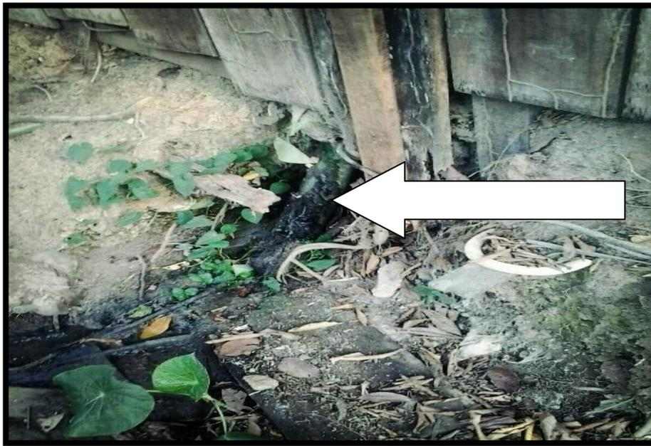
Figura 3 - Cano de esgoto ligado diretamente ao igarapé
